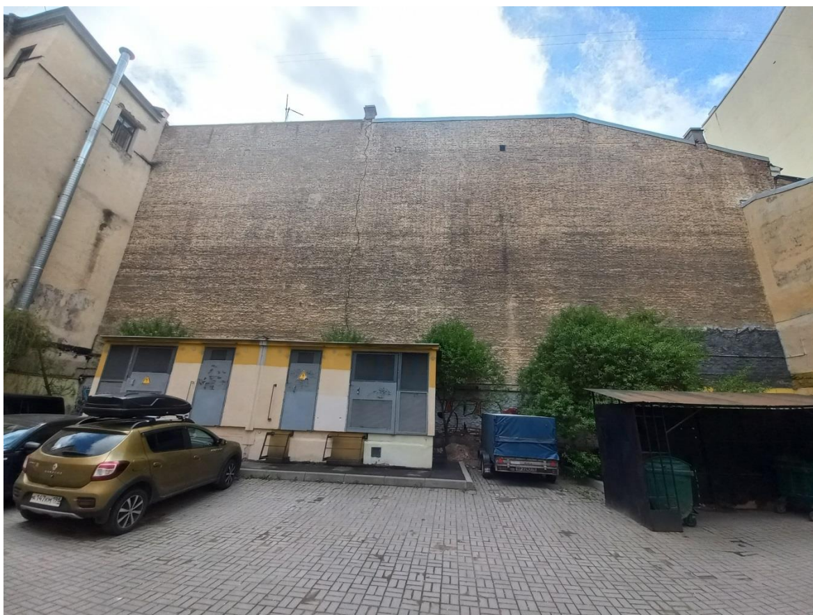
Фото 3. Фасад со стороны д. 39 по наб. р. Фонтанка.
