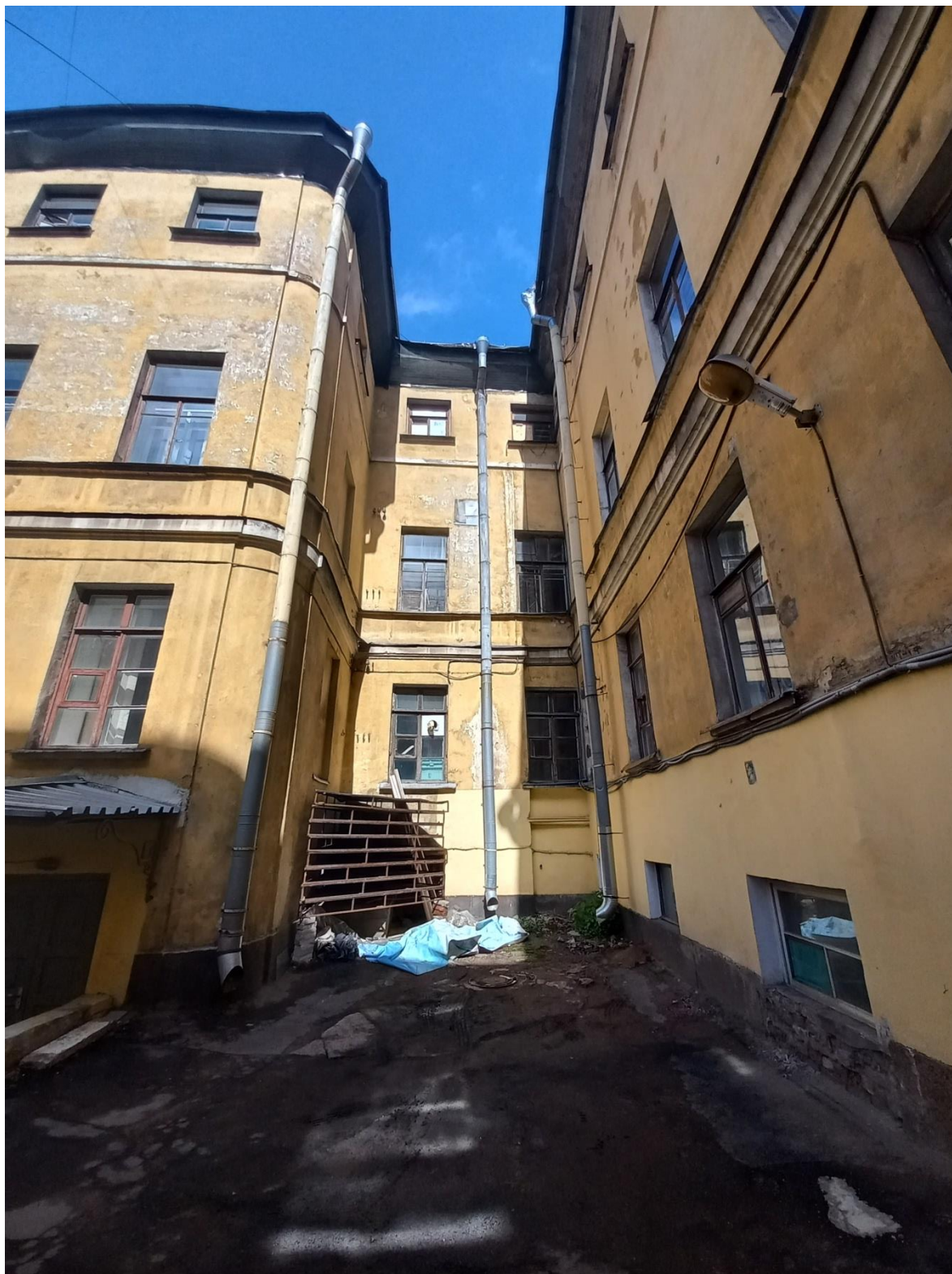
Фото 9. Фасад здания лит. А, южная часть.
