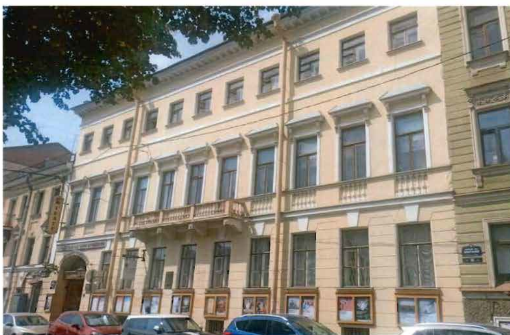
1. Вид на лицевой фасад объекта культурного наследия.
