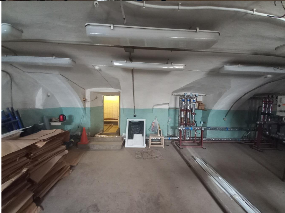
Фото 15 и 16. Помещение 21. Теплоцентр.
