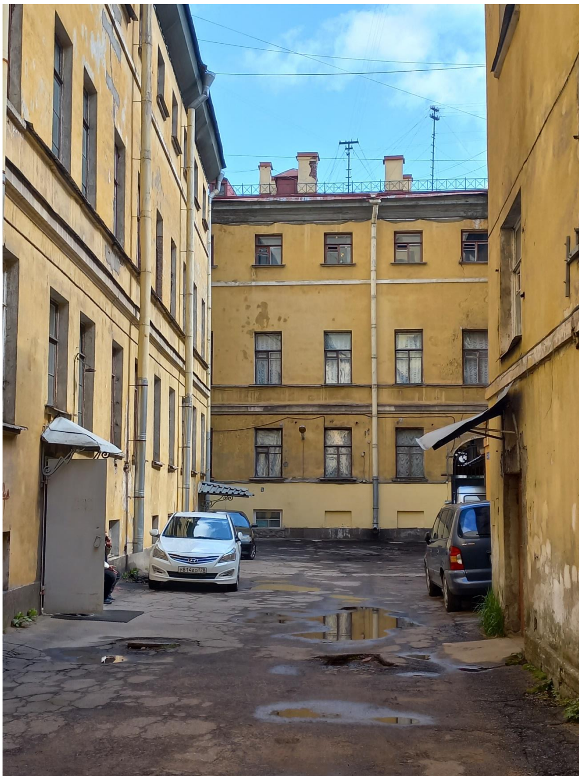
Фото 6. Территория внутреннего двора. Южная часть.
