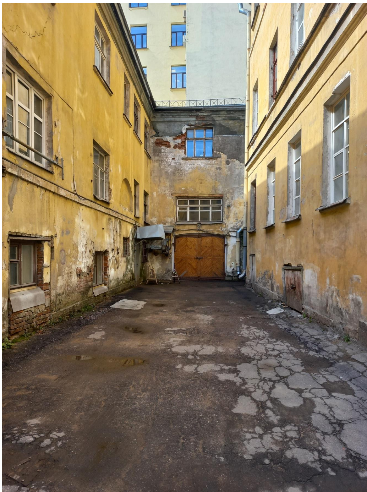
Фото 1. Здания литер А,Б. Северная часть дворовой территории.
