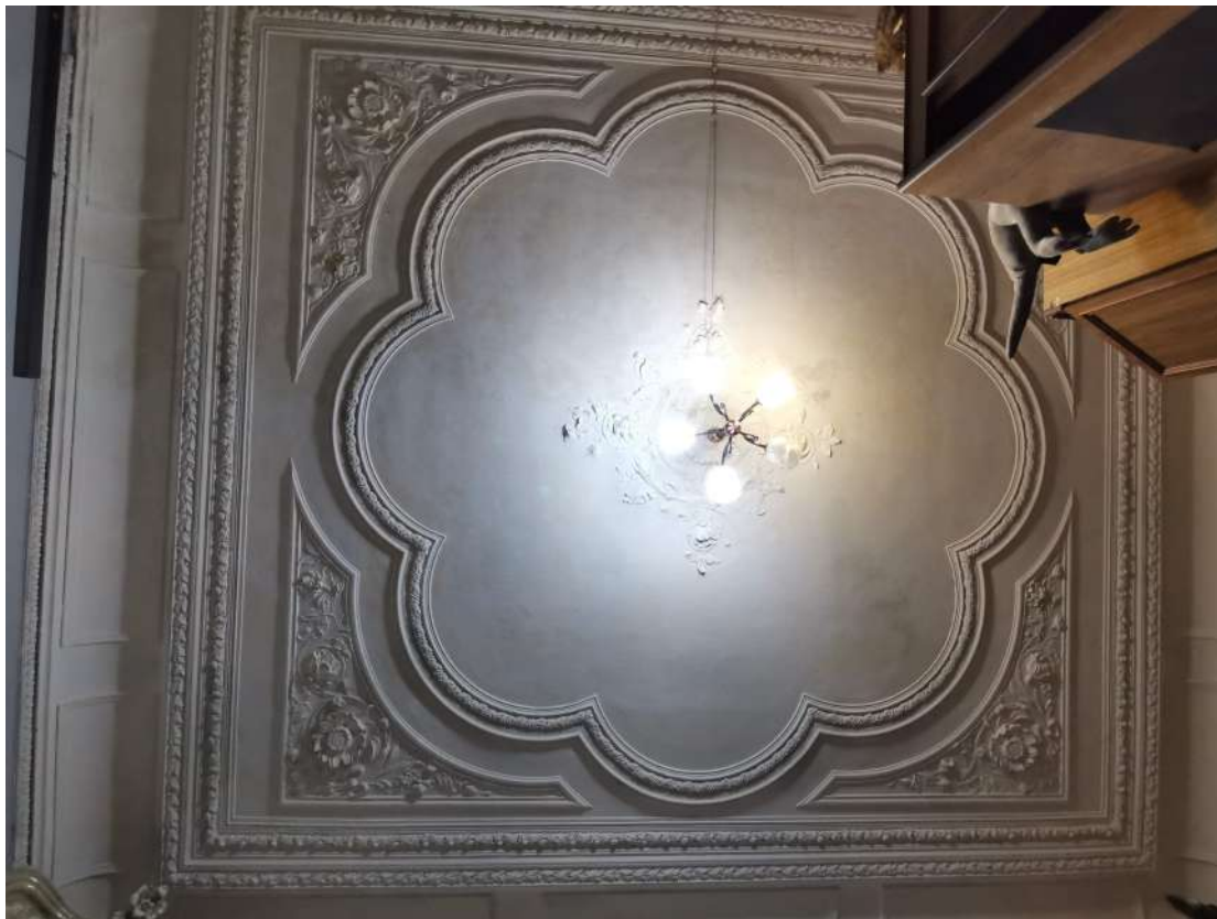
Фото №51. фрагмент потолка помещения (пом.№2 согласно плану ПИБ)
