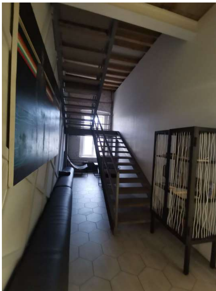
Фото 13. Вид на лестничную клетку 2
