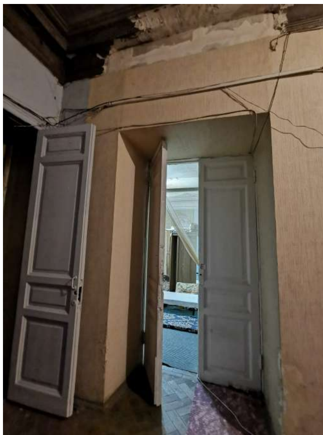
Фото №19. Фрагмент дверного проема помещения (пом.№1 согласно плану ПИБ)
