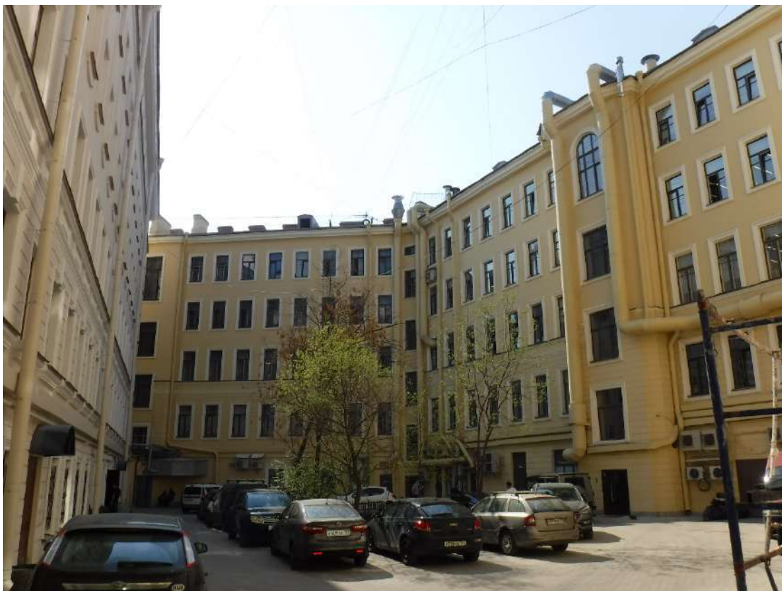
Фото № 5. Общий вид на дворовые фасады
