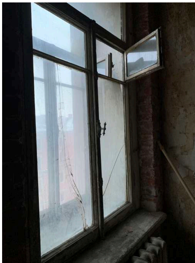
Фото №6. Фрагмент оконного проема помещения (пом.№16 согласно плану ПИБ)
