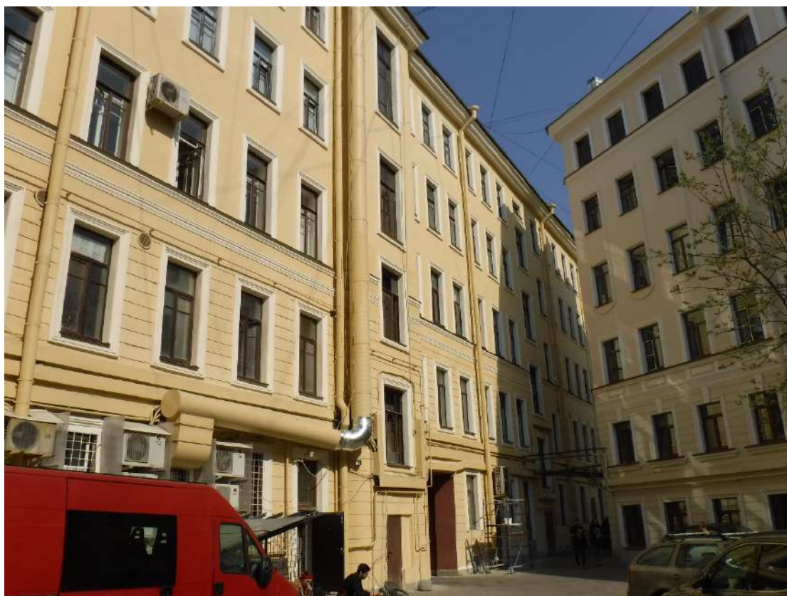
Фото № 9. Фрагмент дворового фасада с дверью ДН-2
