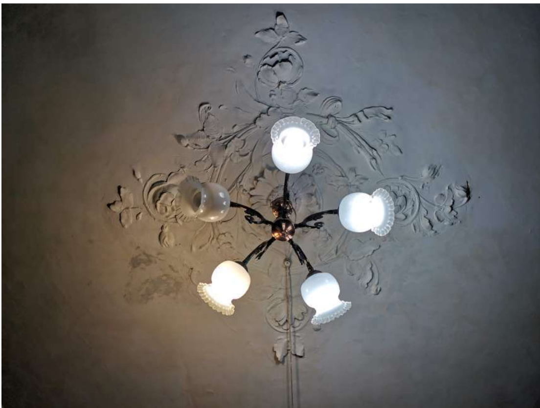
Фото №52. Фрагмент потолка помещения. Разетка. (пом.№2 согласно плану ПИБ)
