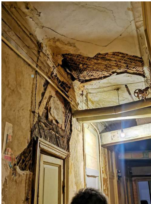
Фото №13. Фрагмент потолка коридора (пом.№6 согласно плану ПИБ)
