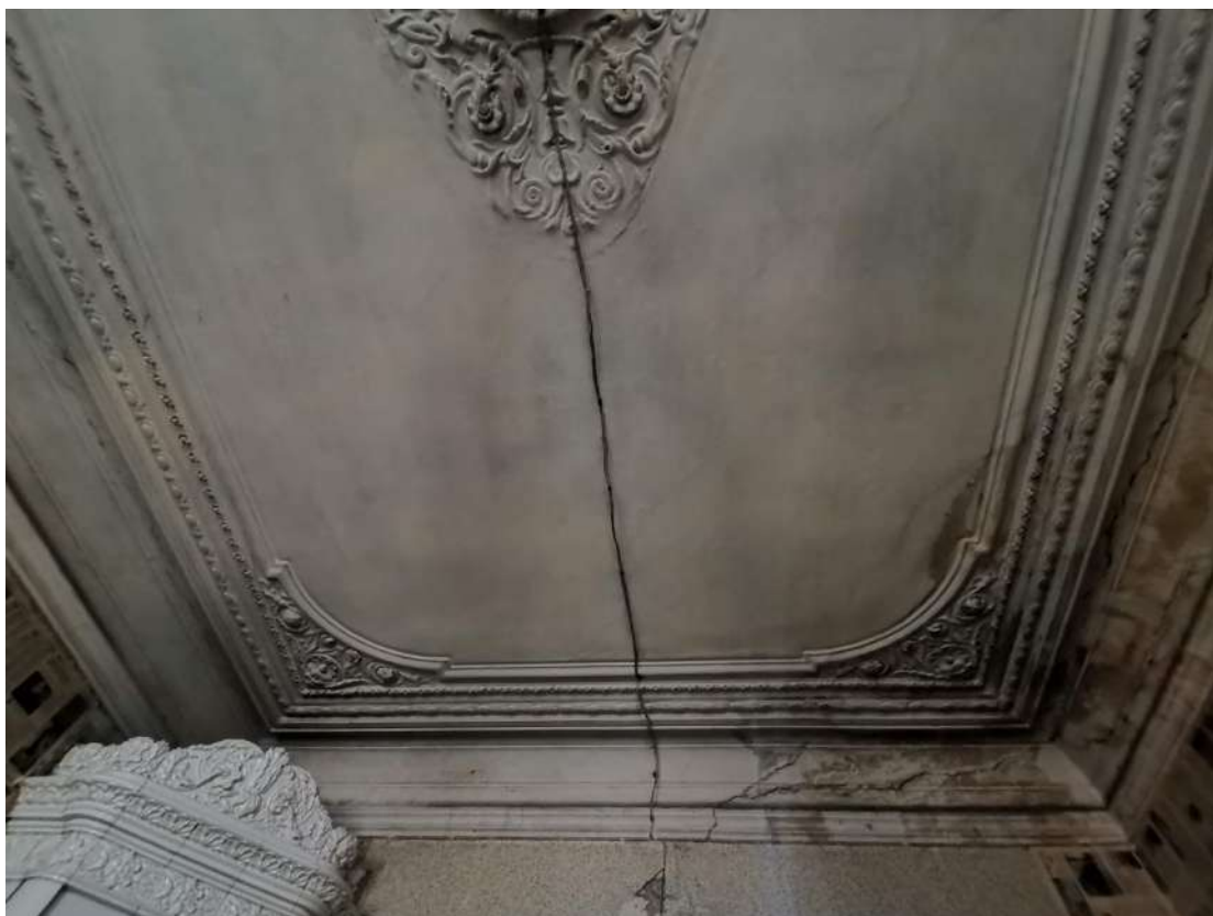
Фото №39. Фрагмент потолка помещения (пом.№16 согласно плану ПИБ)
