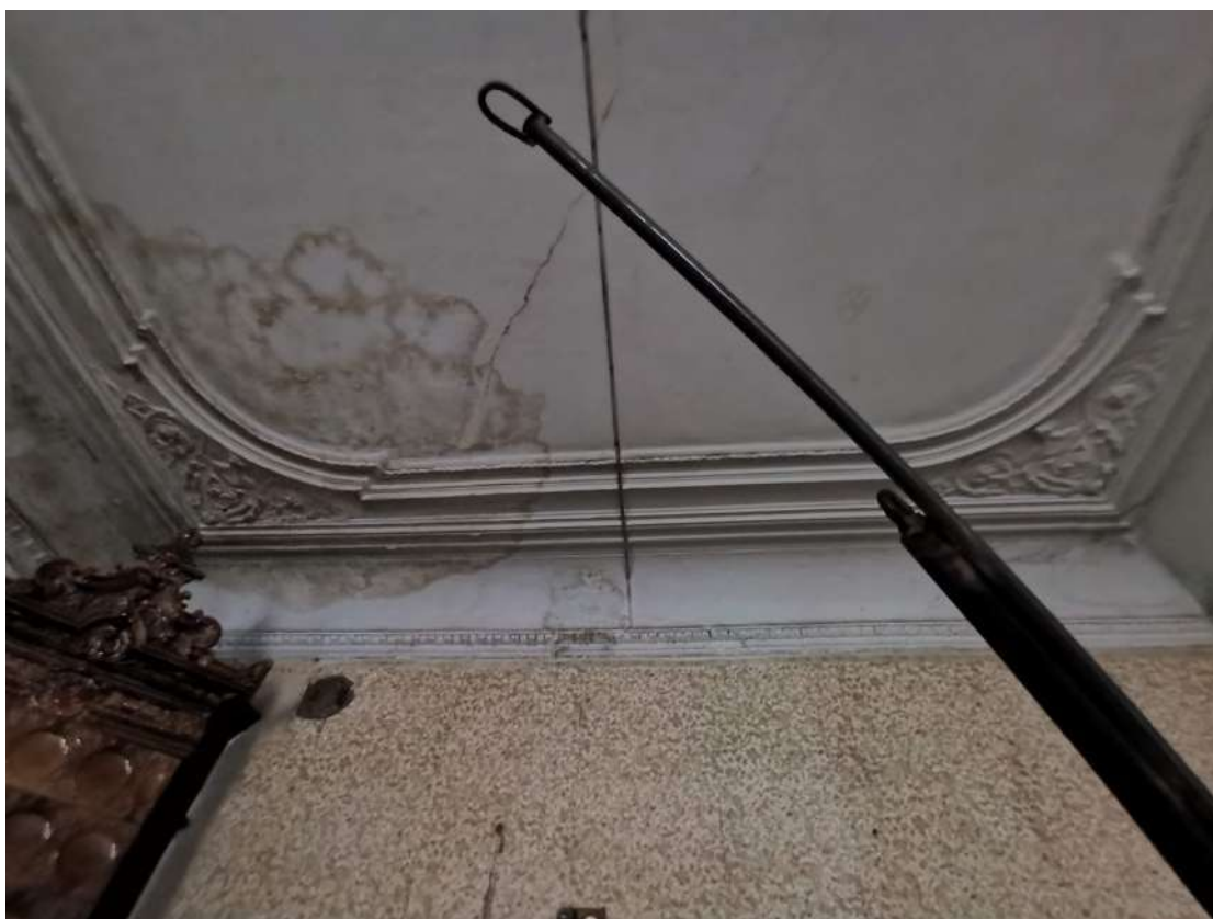
Фото №42. Фрагмент потолка помещения. (пом.№3 Эсогласно плану ПИБ)
