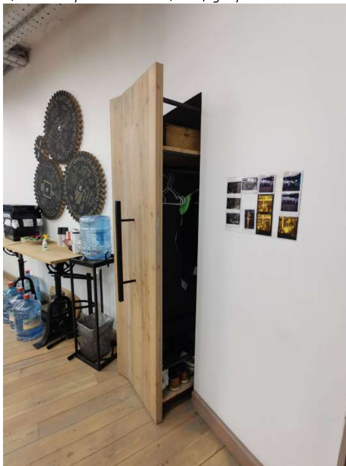
Фото 10. Устройство шкафа в нише
