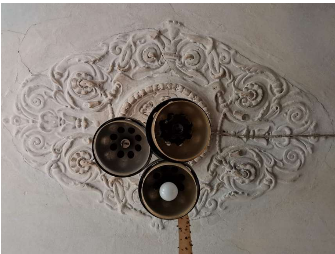
Фото №40. Фрагмент потолка помещения. Розетка (пом.№16 согласно плану ПИБ)
