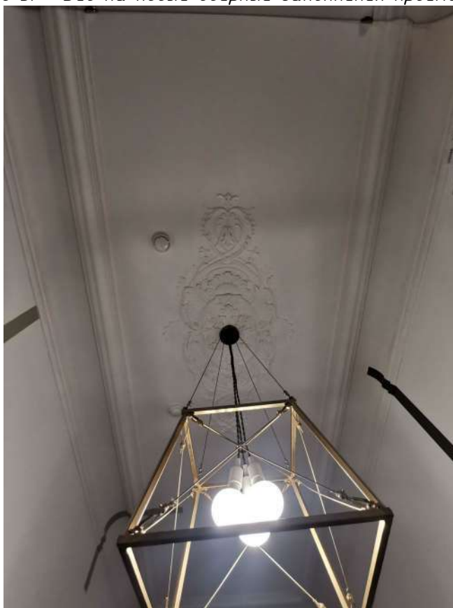
Фото 6. Лепной декор на потолке с профилированной падугой и трехчастной лепной розеткой под люстру.
