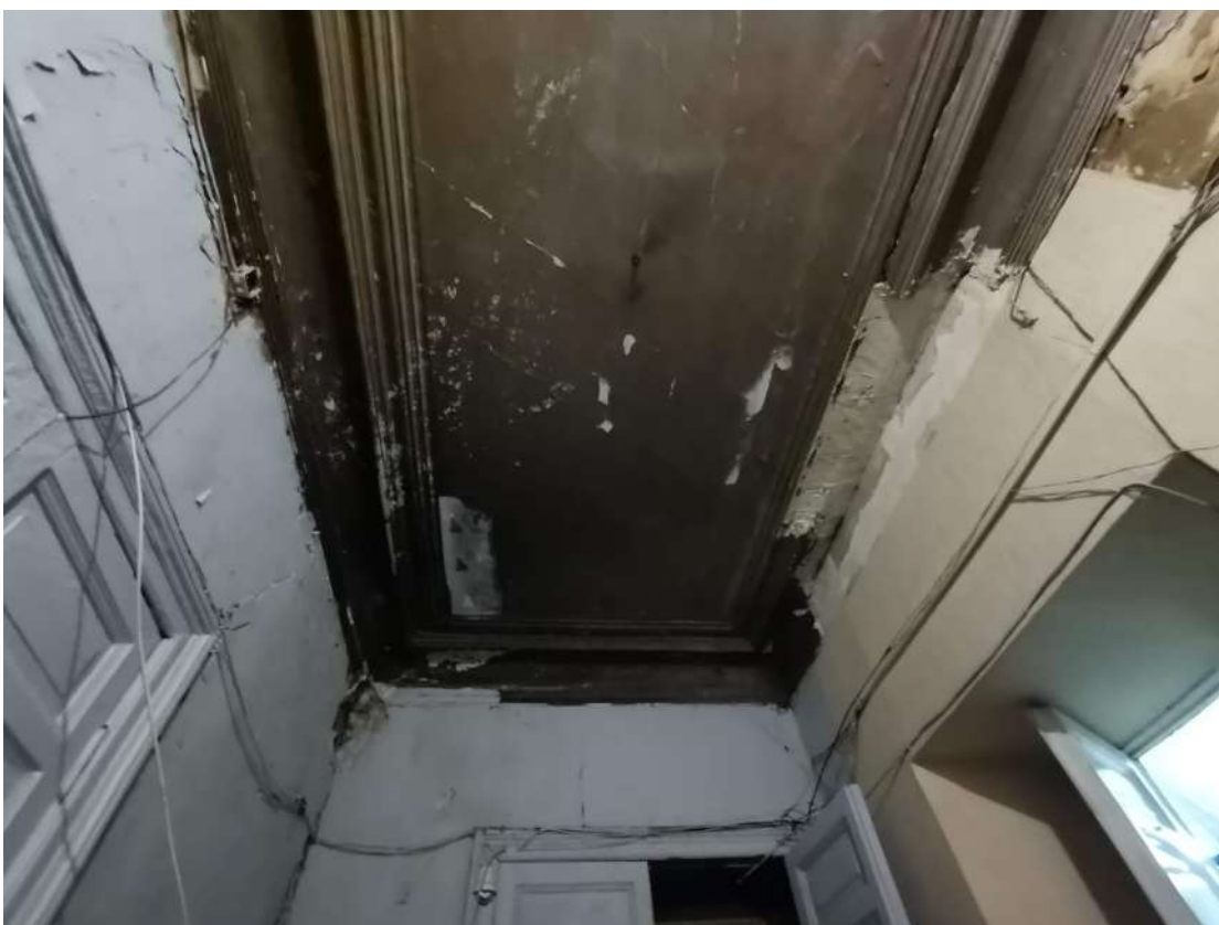
Фото №18. Фрагмент потолка помещения (пом.№1 согласно плану ПИБ)
