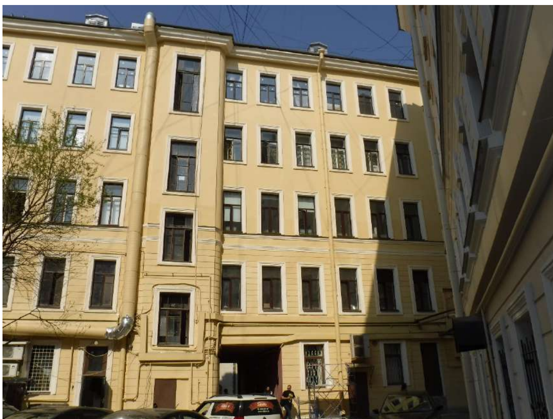
Фото № 10. Фрагмент дворового фасада с дверью ДН-2
