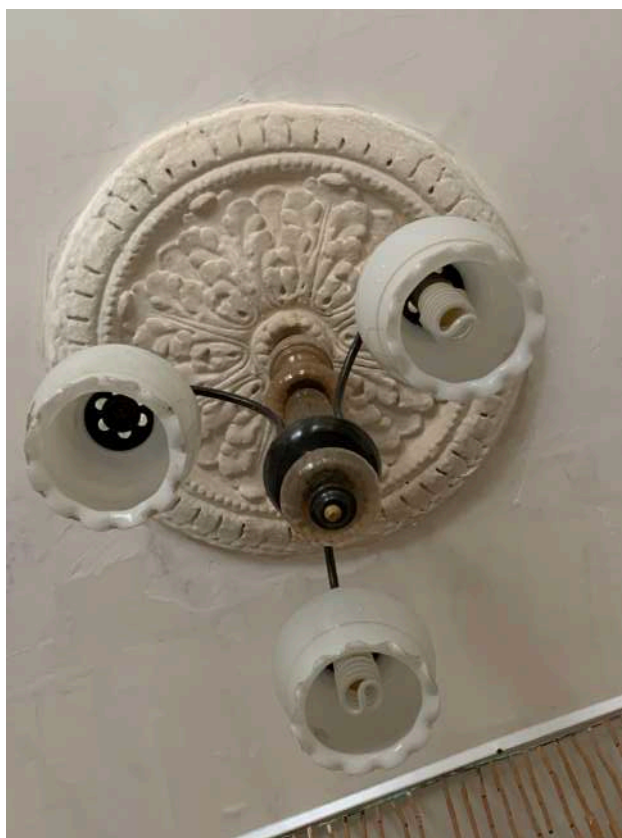
Фото №14. Фрагмент потолка помещения (пом. №4 согласно плану ПИБ)
