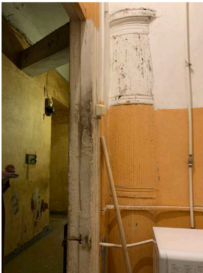
Фото №13. Фрагмент стены помещения ванной комнаты (пом.№5 согласно плану ПИБ)
