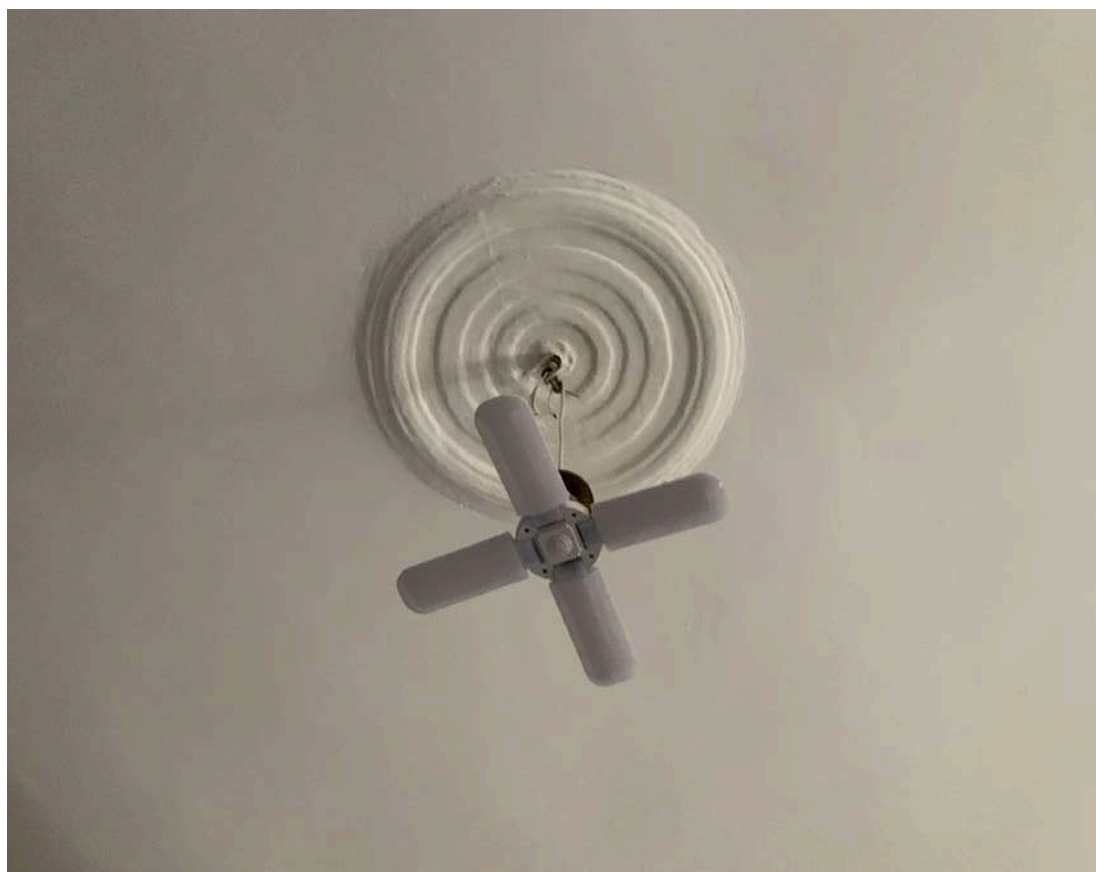
Фото №18. Фрагмент потолка помещения. Розетка (пом. №5 согласно плану ПИБ)
