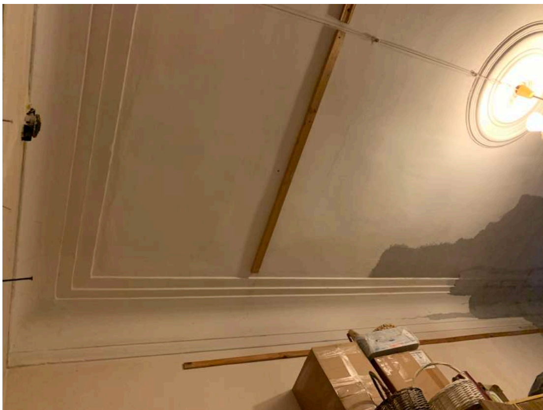
Фото №21. Фрагмент потолка помещения (пом.№3 согласно плану ПИБ)
