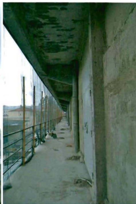
Фото 10. Открытая галерея на южном фасаде.
