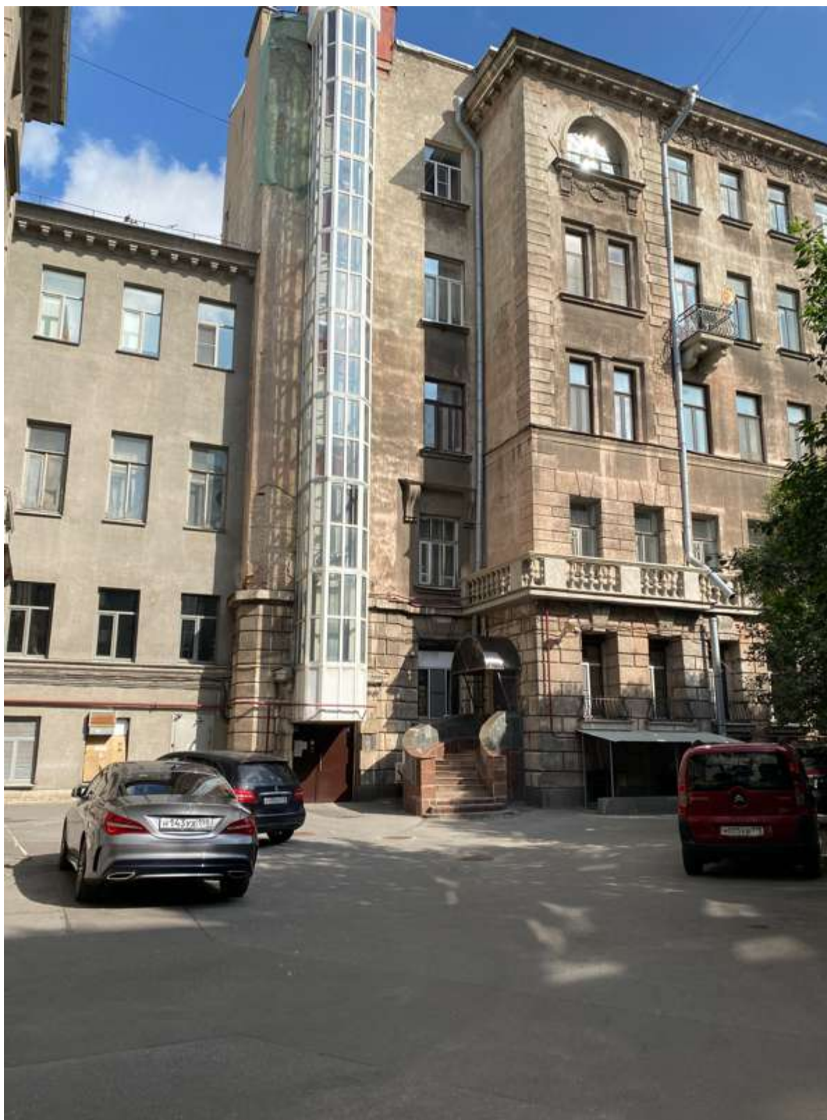
8. Фрагмент дворового фасада
