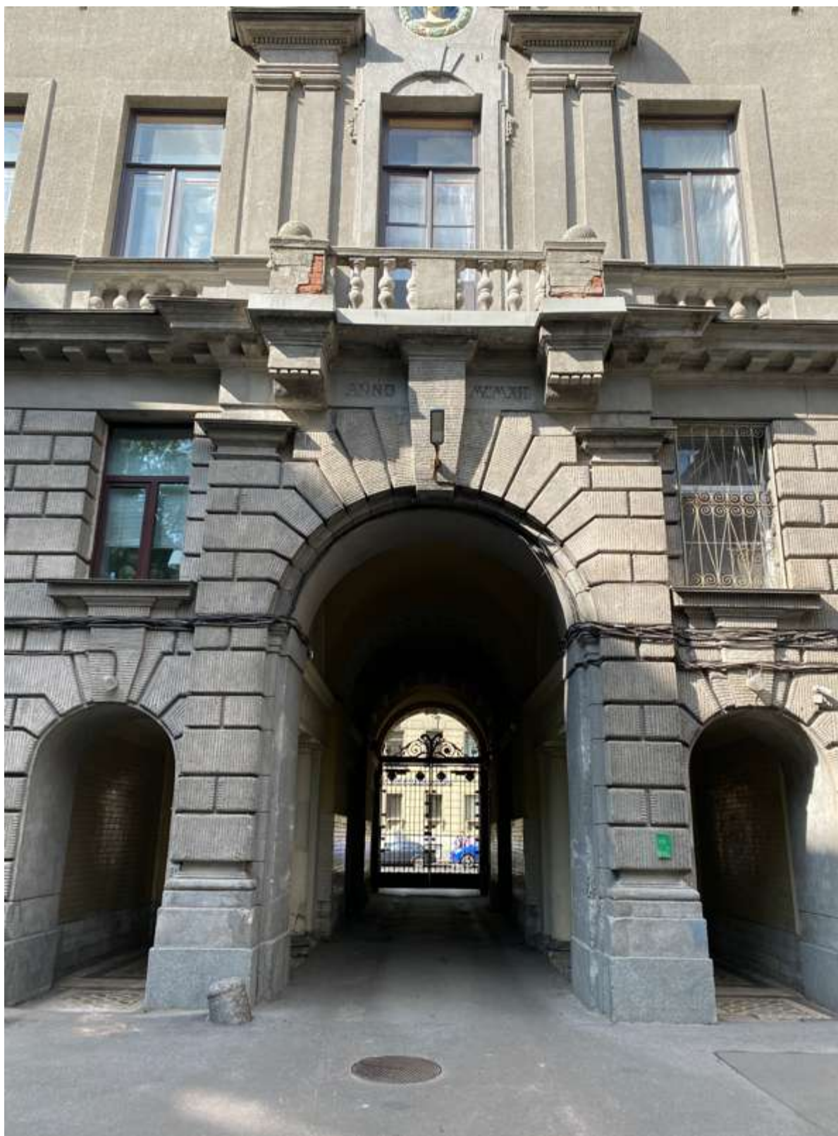
11. Фрагмент дворового фасада
