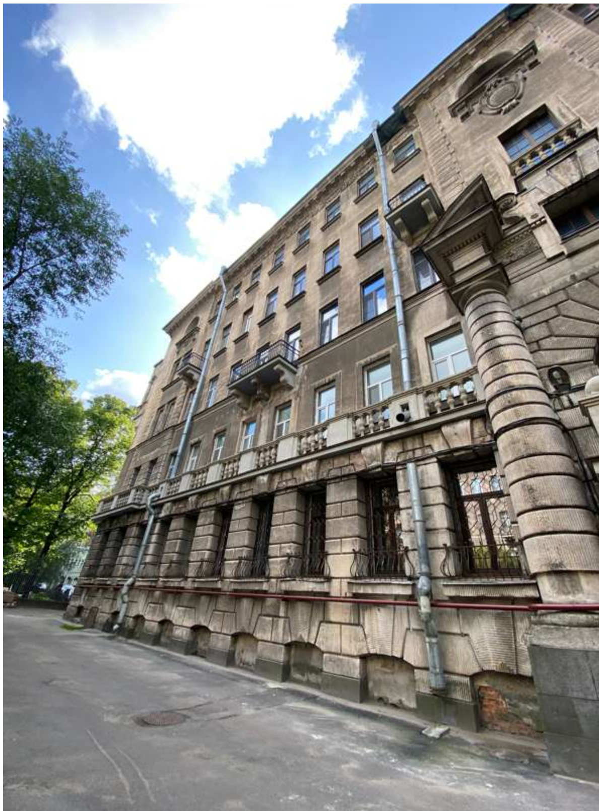
22. Фрагмент дворового фасада
