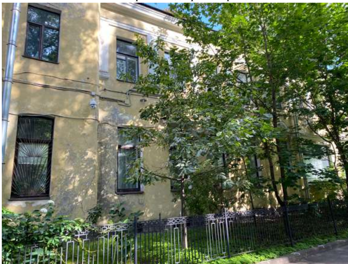
17. Фрагмент дворового фасада
