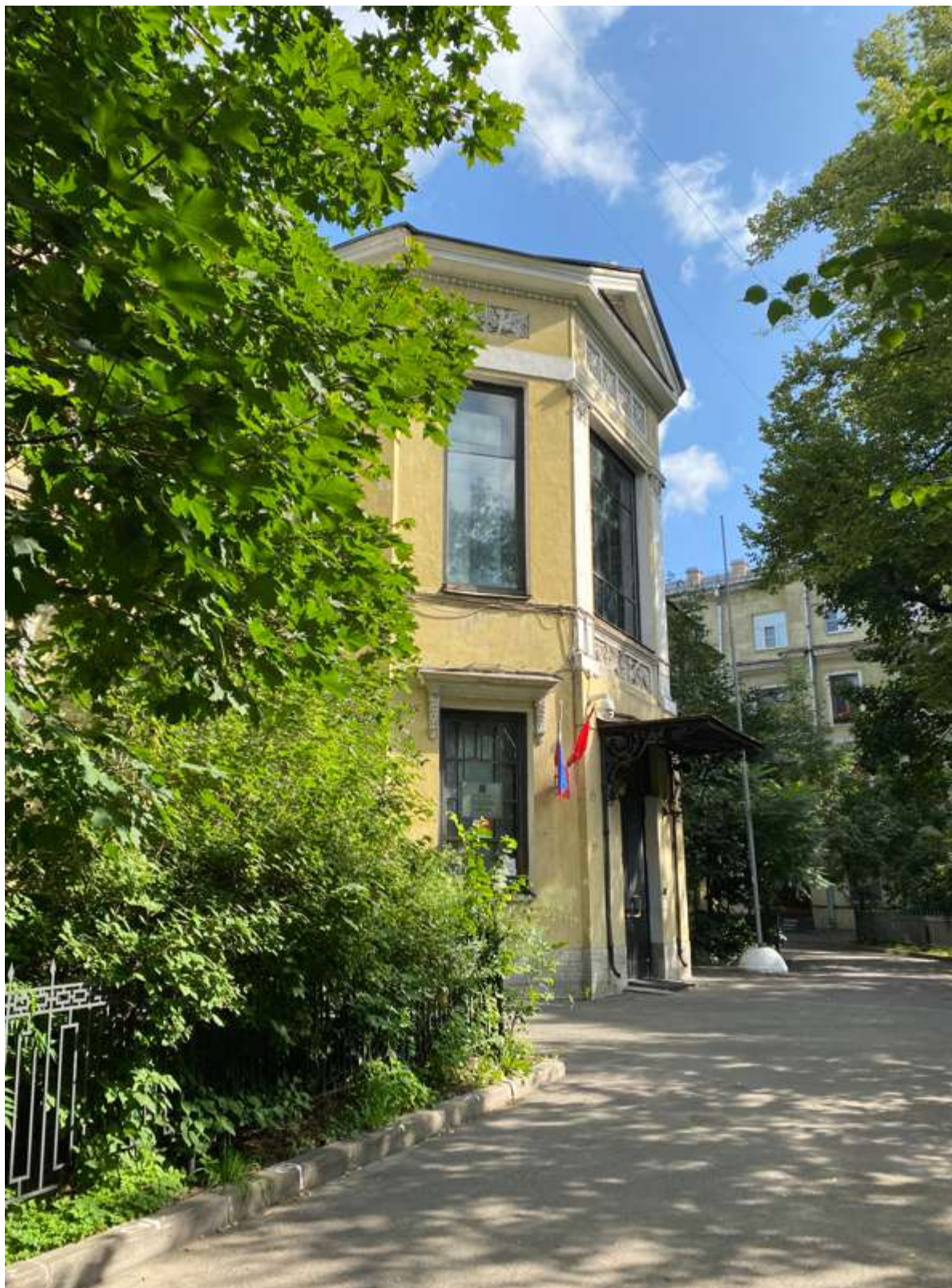
19. Фрагмент дворового фасада
