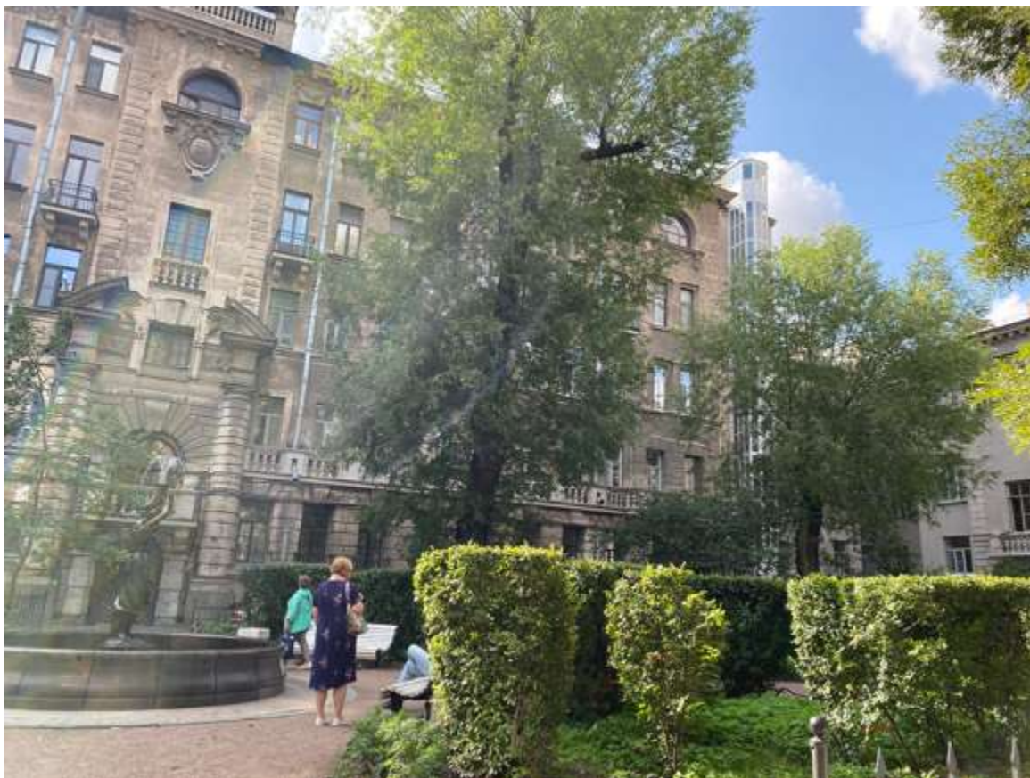
16. Фрагмент дворового фасада
