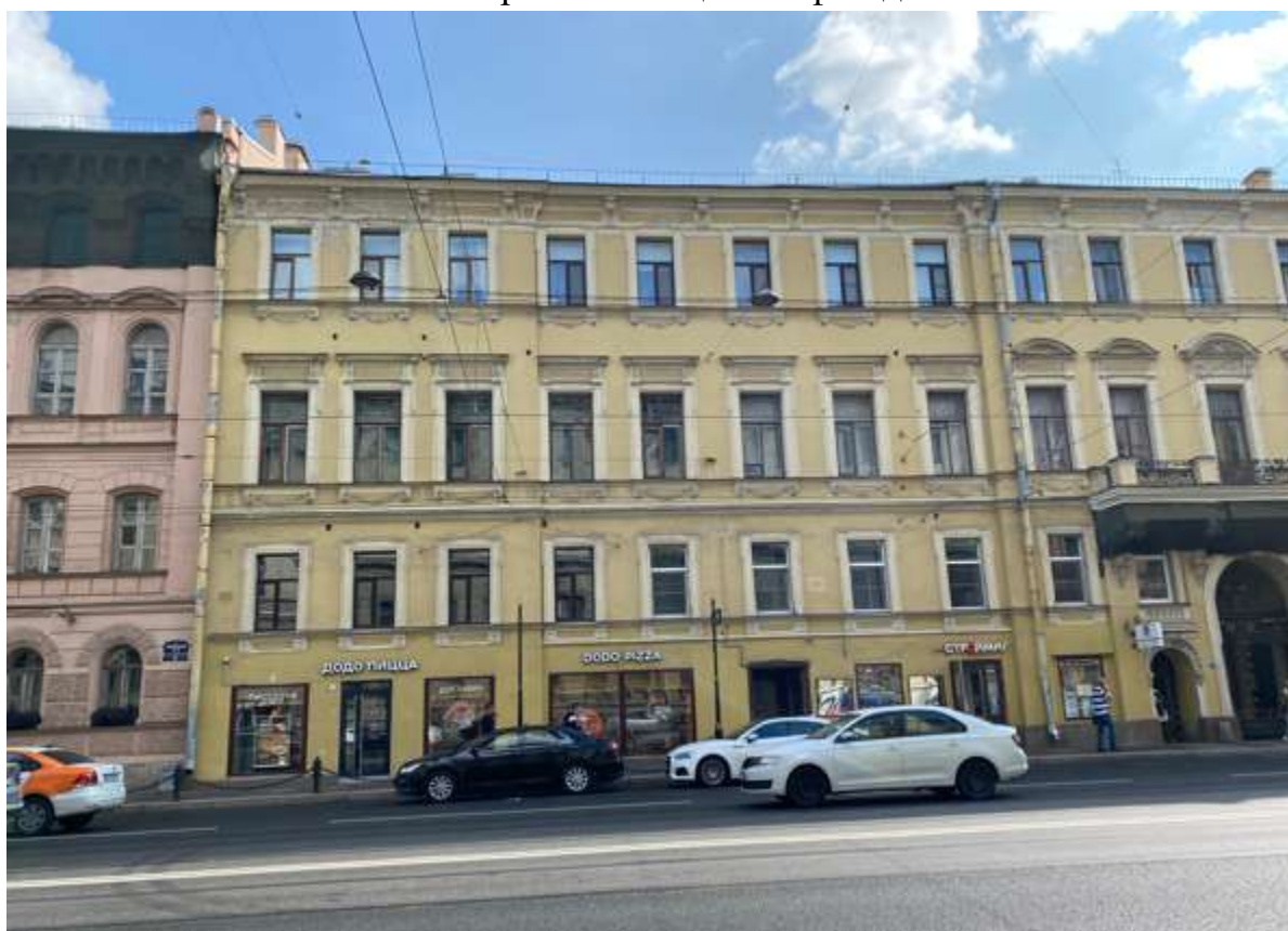
4. Фрагмент лицевого фасада
