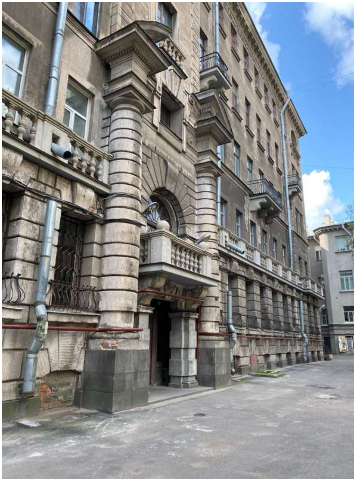
21. Фрагмент дворового фасада
