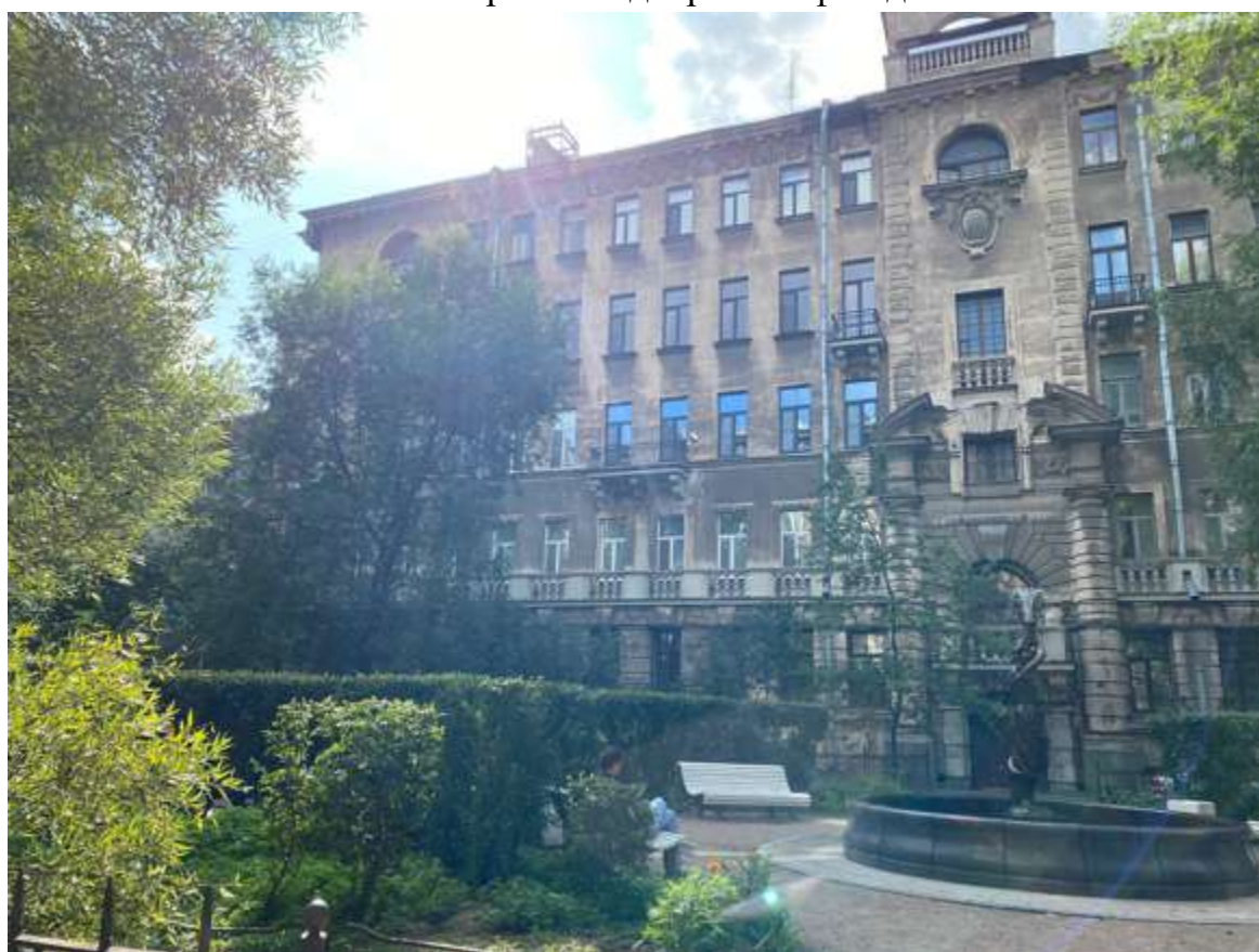
15. Фрагмент дворового фасада
