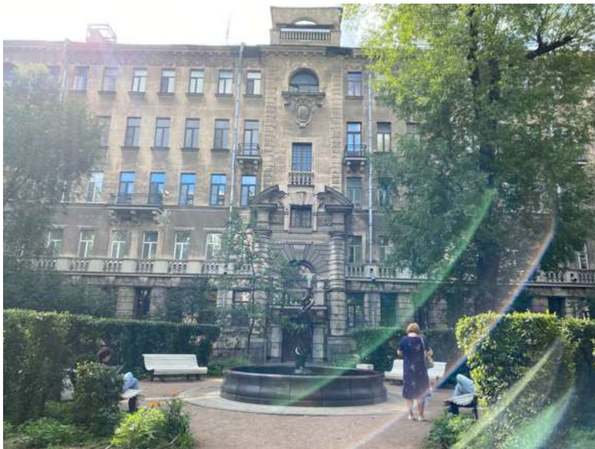
14. Фрагмент дворового фасада
