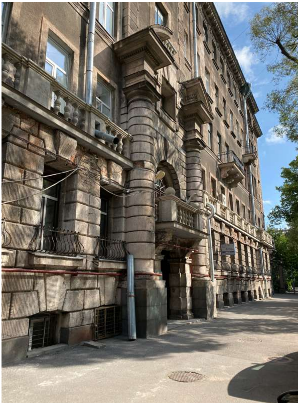
13. Фрагмент дворового фасада
