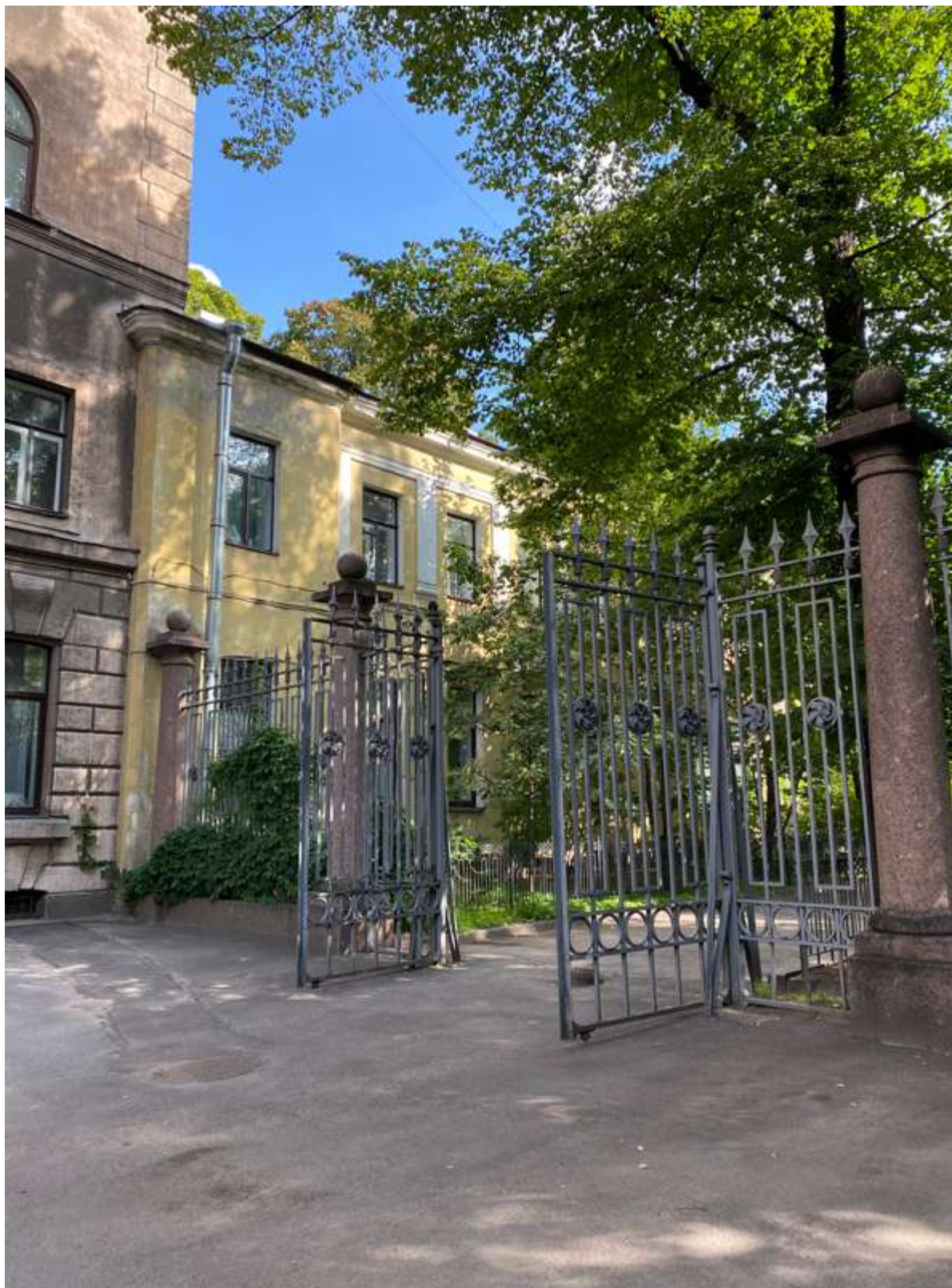
18. Фрагмент дворового фасада
