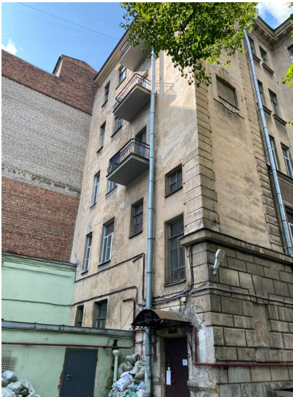
20. Фрагмент дворового фасада
