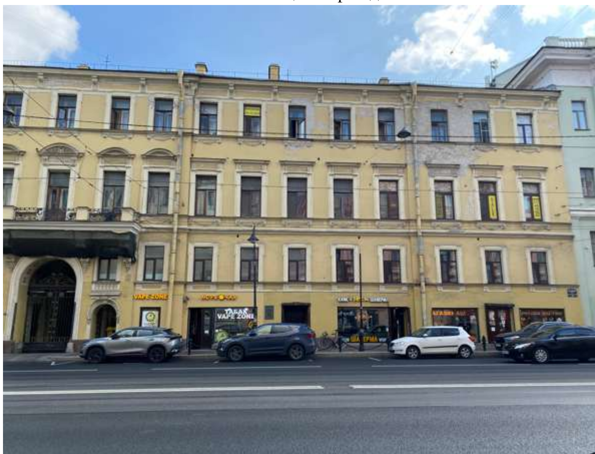
2. Фрагмент лицевого фасада
