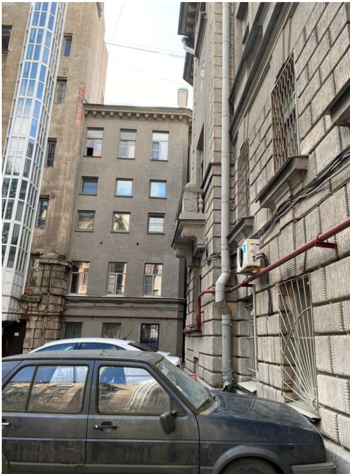
10. Фрагмент дворового фасада
