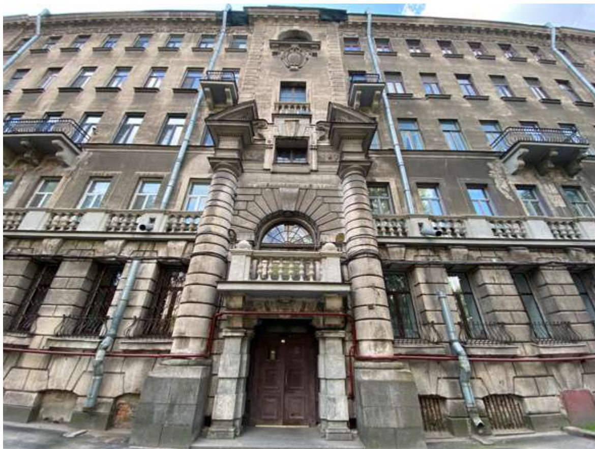
23. Фрагмент дворового фасада
