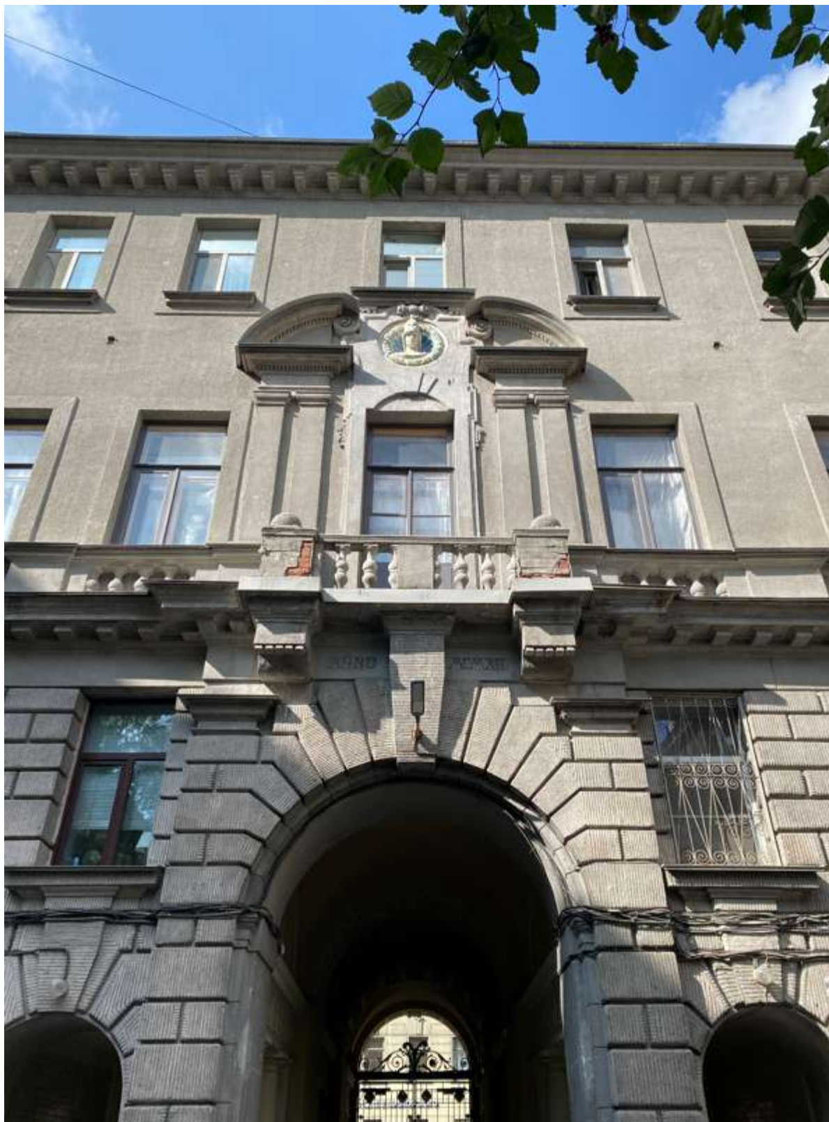
12. Фрагмент дворового фасада
