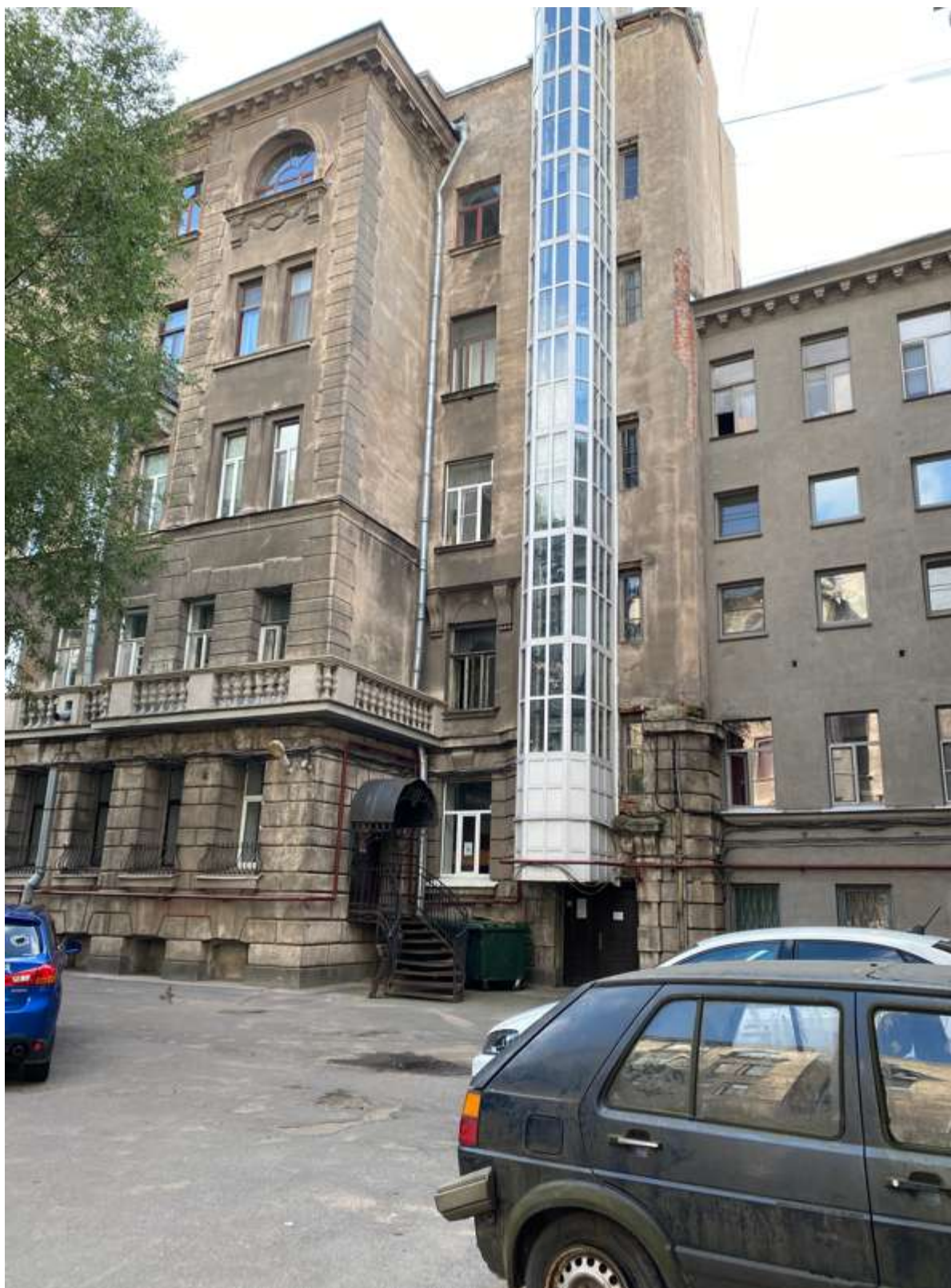
9. Фрагмент дворового фасада
