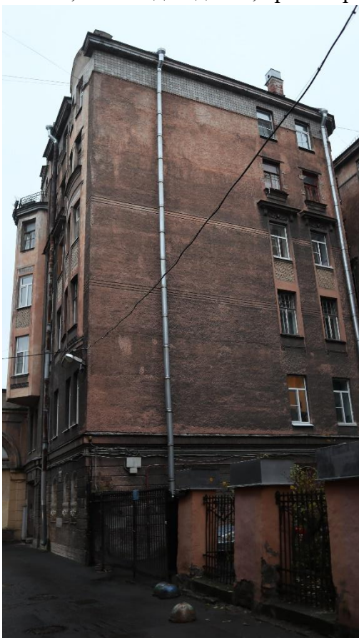
Фото 9. Фасад здания, выходящий на курдонёр.
