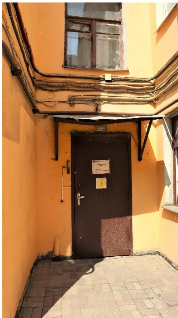
Фото 4. Дворовый фасад, фрагмент.
