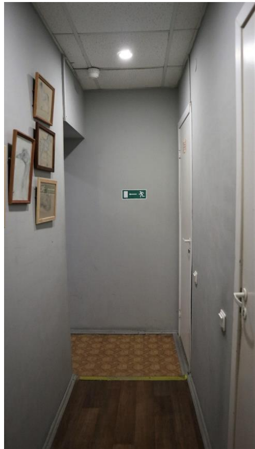
Фото 1.22. Цокольный этаж, коридор, помещение ЗН (8).
