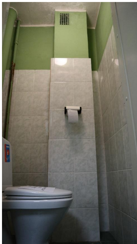
Фото 1.19. Цокольный этаж, санузел, помещение 3Н (3).
