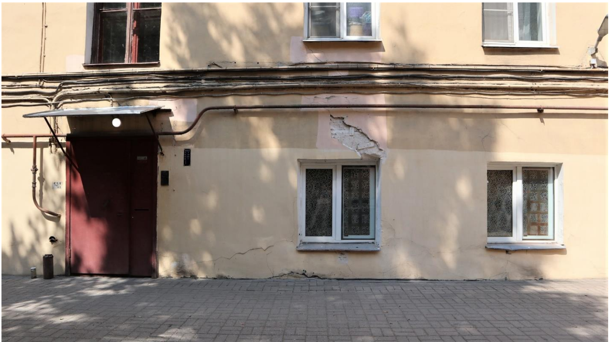
Фото 7. Дворовый фасад, фрагмент.
