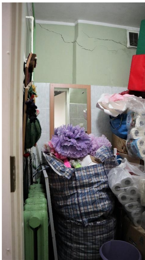
Фото 1.18. Цокольный этаж, помещение 3Н (2).
