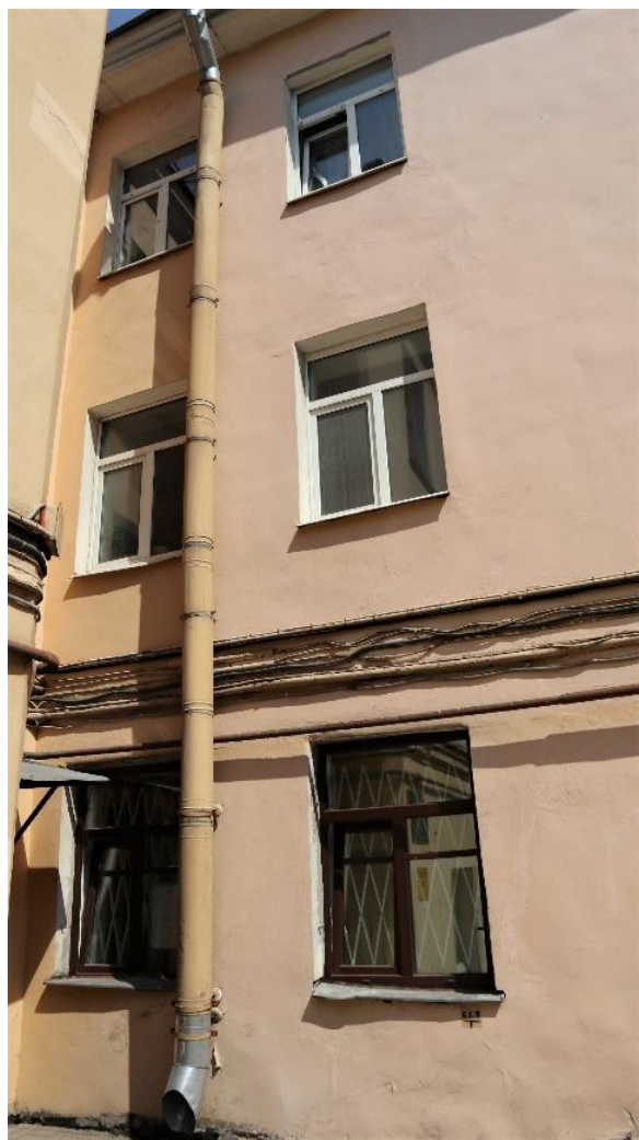
Фото 5. Дворовый фасад, фрагмент.
