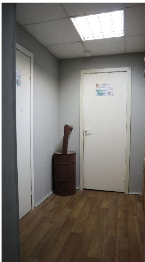
Фото 1.4. цокольный этаж, коридор, помещение ЗН (10).
