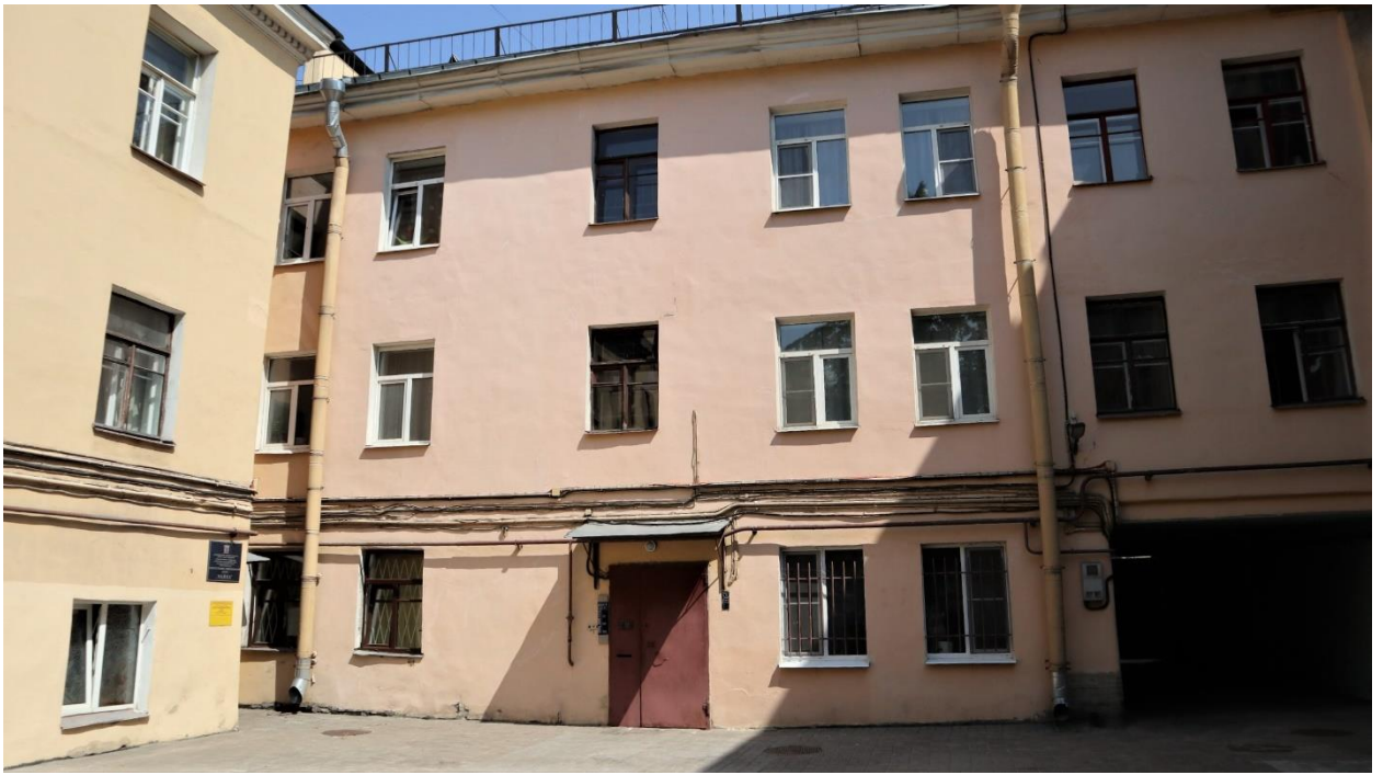
Фото 6. Дворовый фасад, фрагмент.
