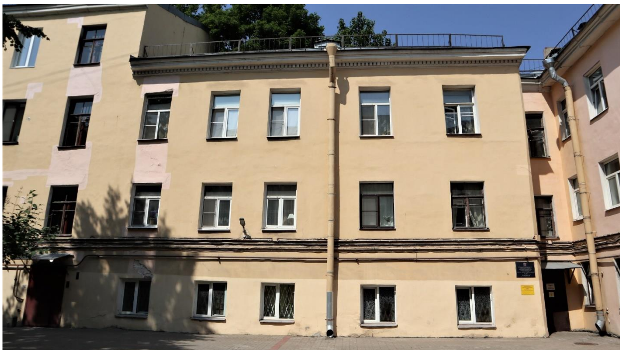
Фото 3. Дворовый фасад, фрагмент.
