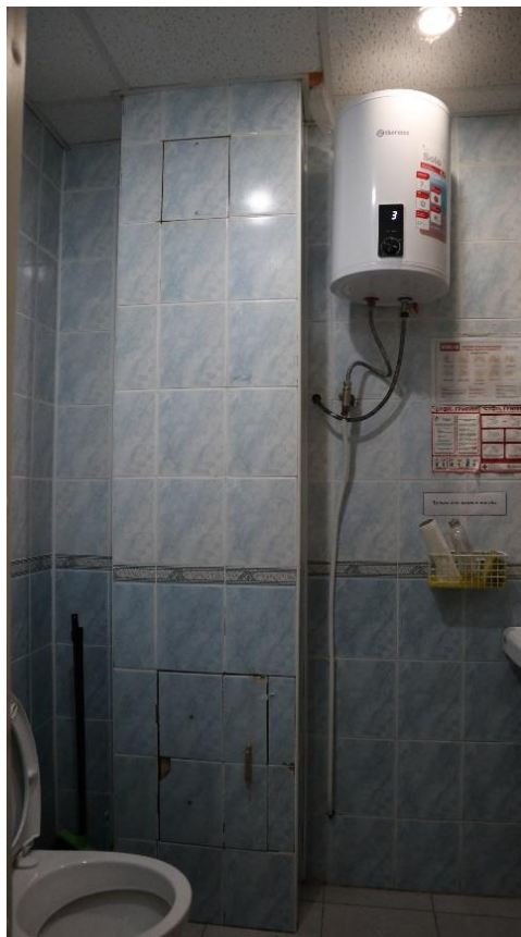
Фото 1.10. Цокольный этаж, санузел, помещение ЗН (6).
