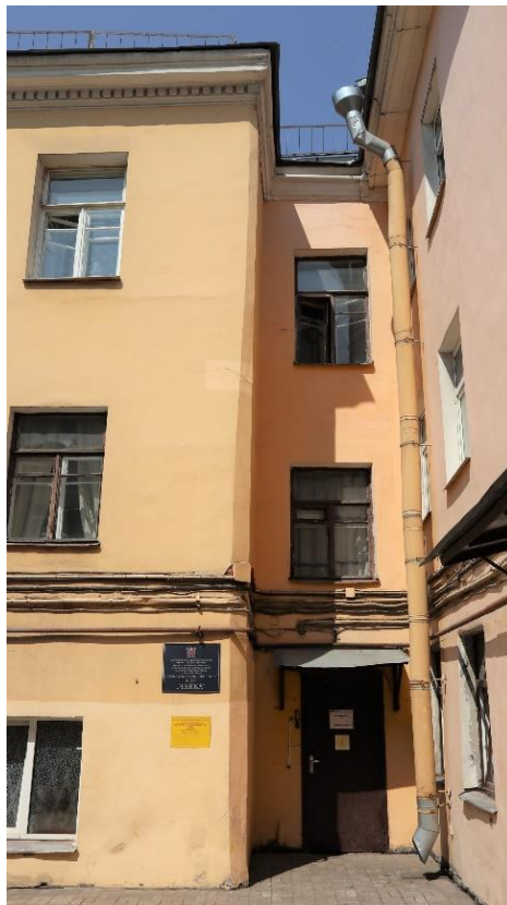
Фото 2. Дворовый фасад, фрагмент.
