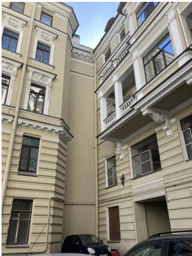
Фото 11. Фрагмент дворового фасада объекта культурного наследия регионального значения «Дом Я.В. Ратькова-Рожнова»
