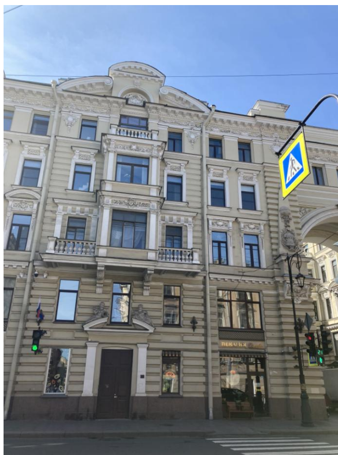
Фото 2. Фрагмент лицевого фасада объекта культурного наследия регионального значения «Дом Я.В. Ратькова-Рожнова»
