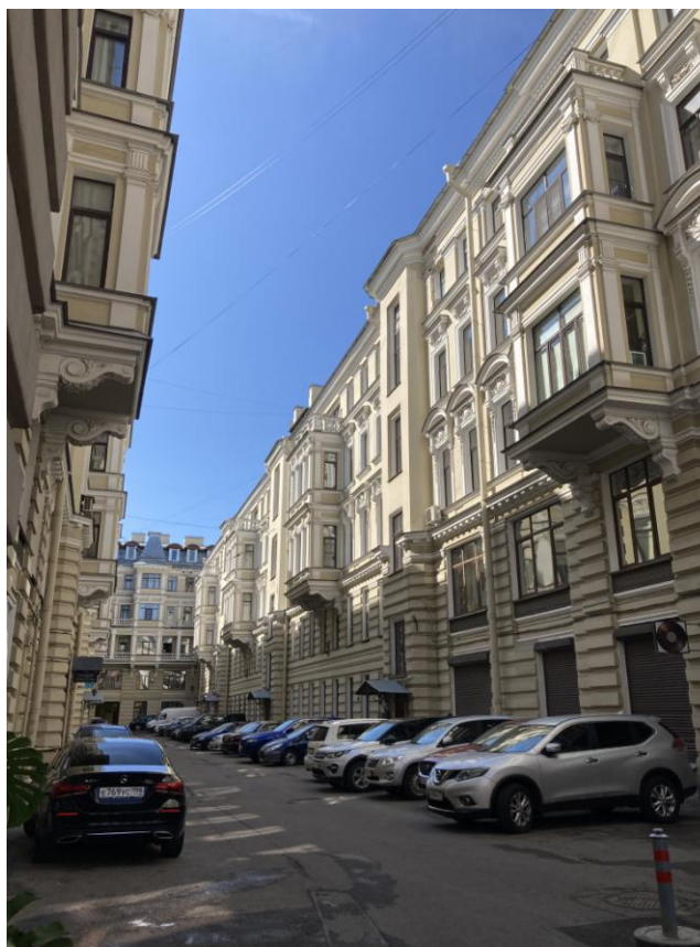
Фото 6. Фрагмент дворового фасада объекта культурного наследия регионального значения «Дом Я.В. Ратькова-Рожнова»
