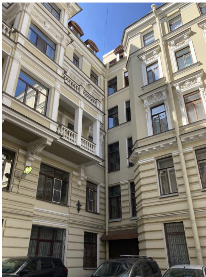
Фото 10. Фрагмент дворового фасада объекта культурного наследия регионального значения «Дом Я.В. Ратькова-Рожнова»
