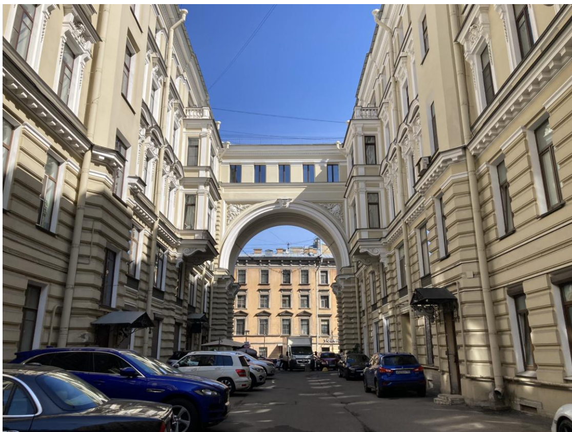
Фото 13. Фрагмент дворового фасада объекта культурного наследия регионального значения «Дом Я.В. Ратькова-Рожнова»
