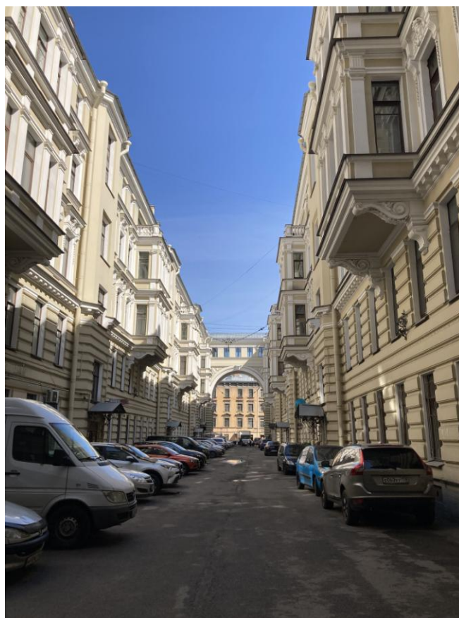
Фото 12. Фрагмент дворового фасада объекта культурного наследия регионального значения «Дом Я.В. Ратькова-Рожнова»
