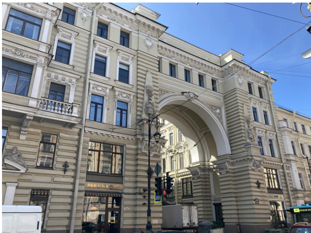
Фото 1. Фрагмент лицевого фасада объекта культурного наследия регионального значения «Дом Я.В. Ратькова-Рожнова»
