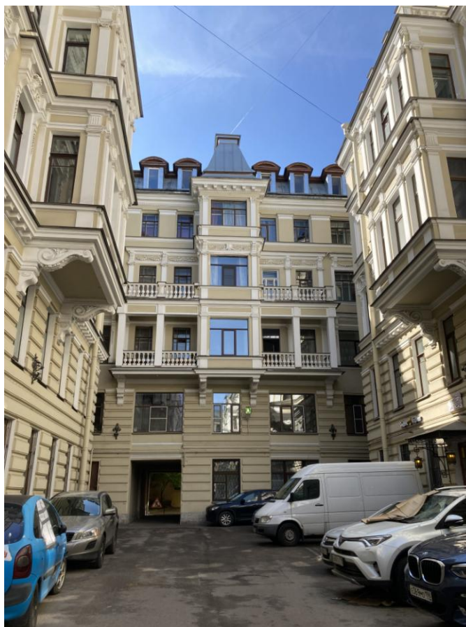
Фото 9. Фрагмент дворового фасада объекта культурного наследия регионального значения «Дом Я.В. Ратькова-Рожнова»
