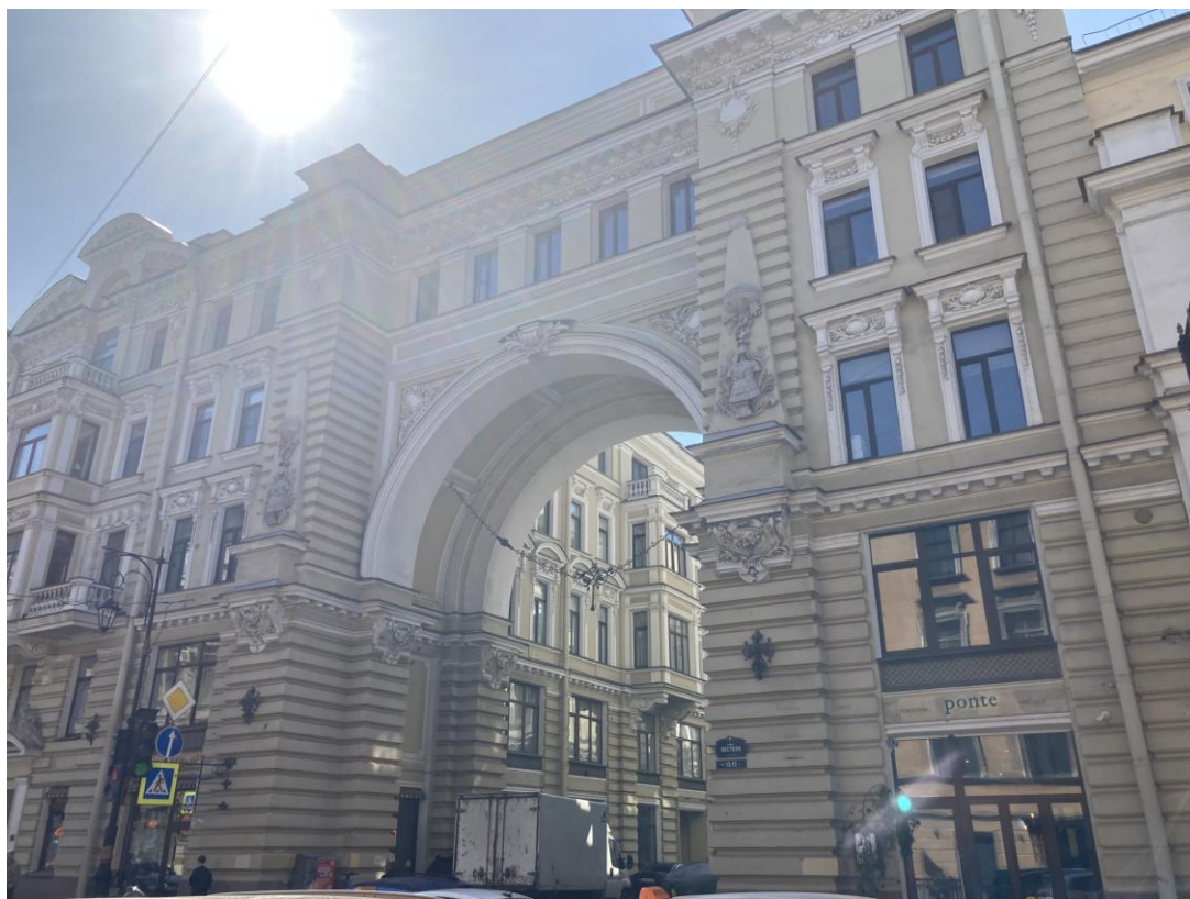
Фото 3. Фрагмент лицевого фасада объекта культурного наследия регионального значения «Дом Я.В. Ратькова-Рожнова»
