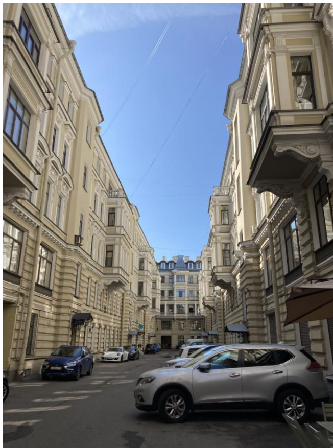
Фото 7. Фрагмент дворового фасада объекта культурного наследия регионального значения «Дом Я.В. Ратькова-Рожнова»
