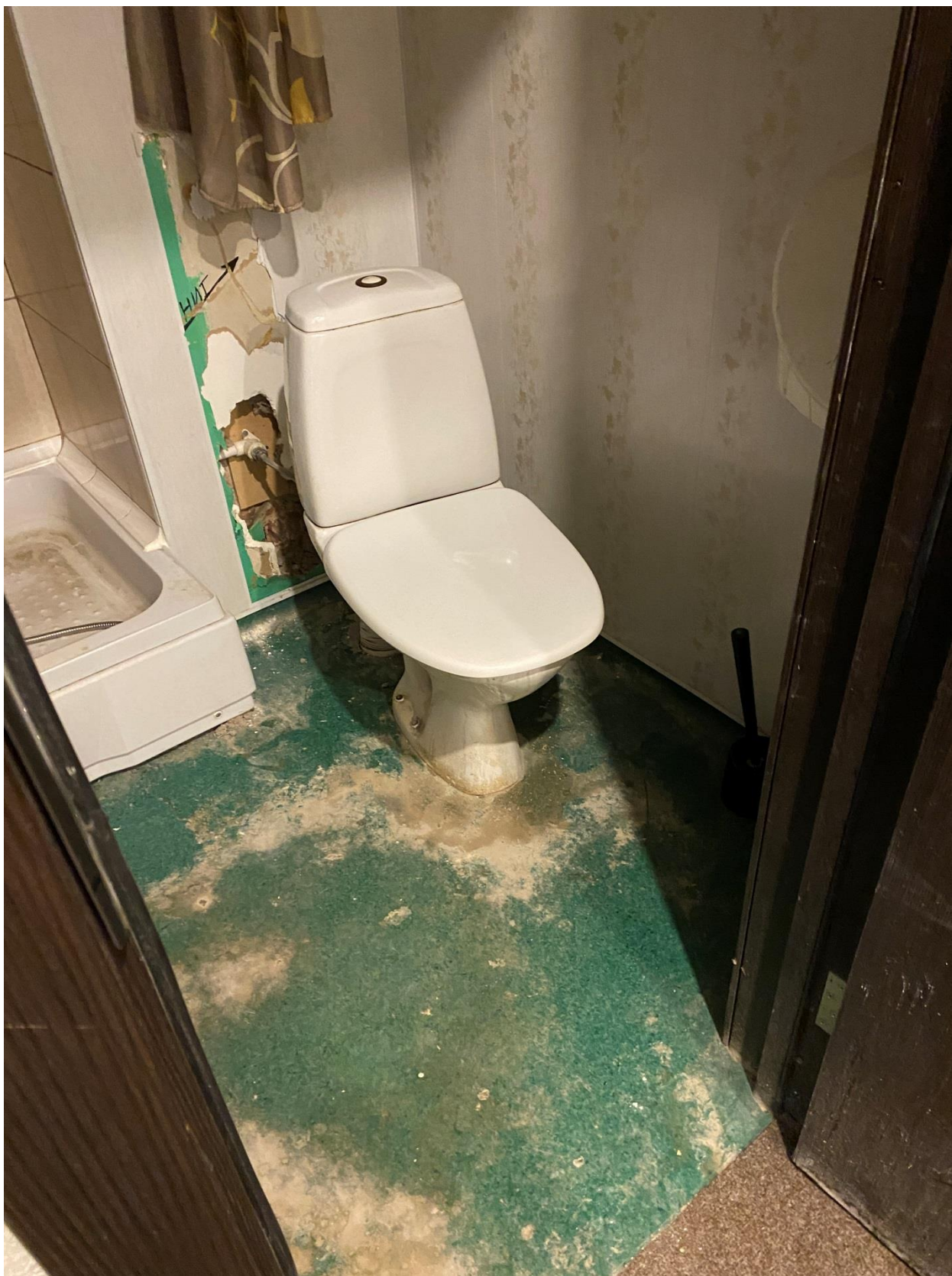
Фото 60. Вид на помещение квартиры № 10 объекта культурного наследия.
