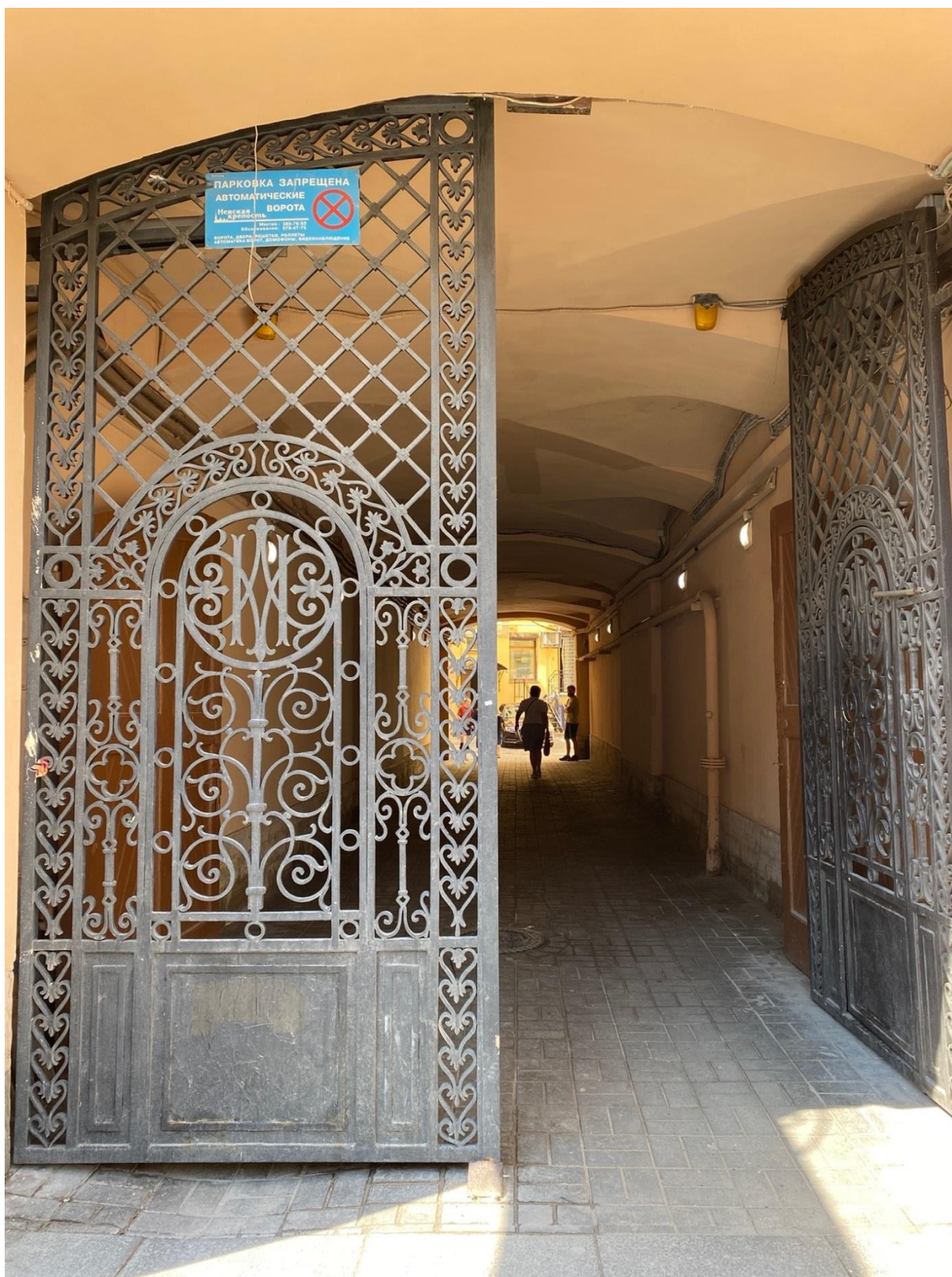
Фото 5. Вид на заполнение воротного проезда, ведущего во двор объекта культурного наследия.
