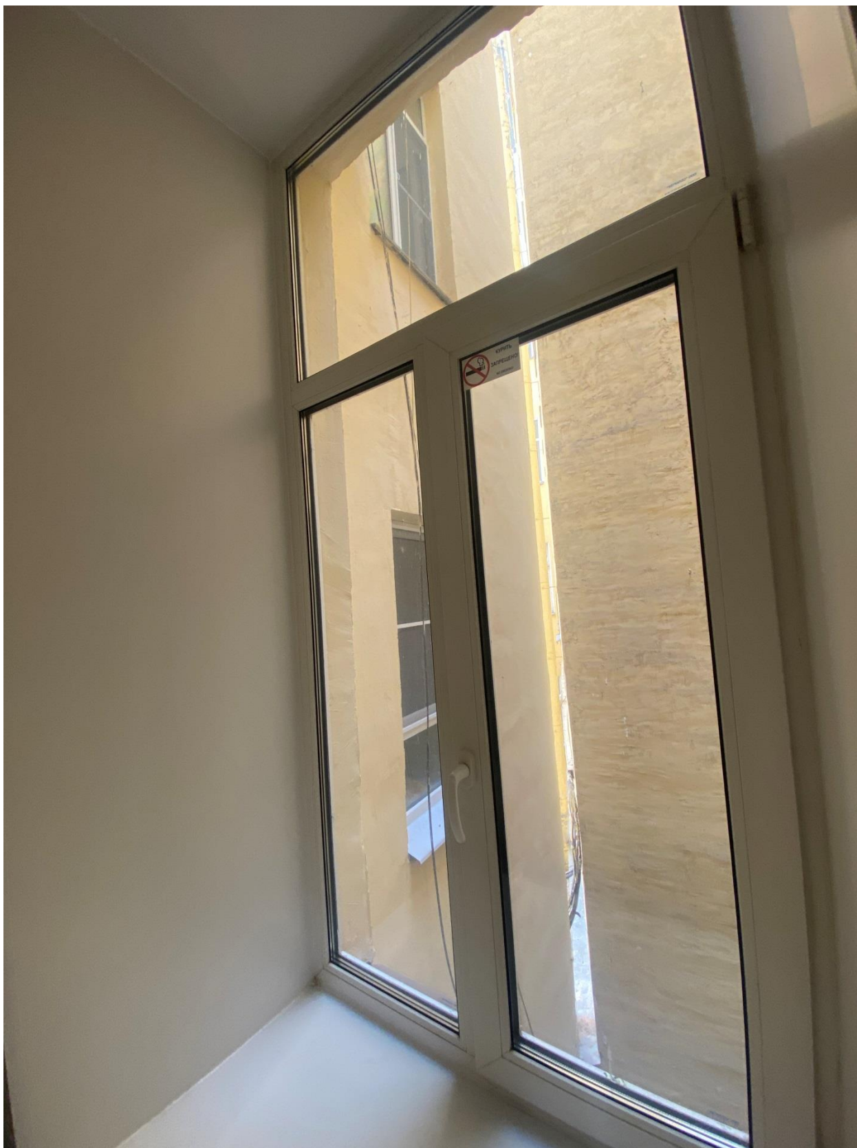
Фото 41. Вид на оконное заполнение квартиры № 10 объекта культурного наследия.
