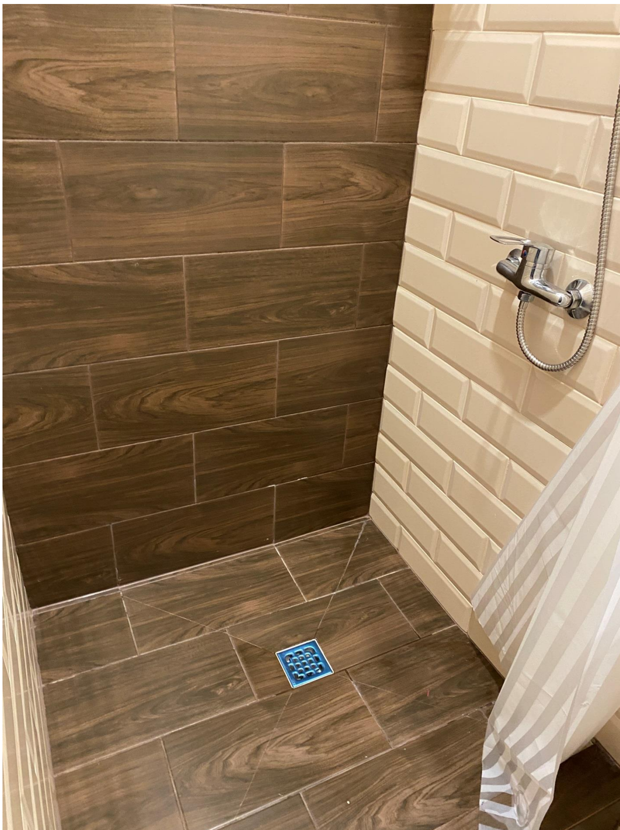
Фото 28. Вид на помещение квартиры № 10 объекта культурного наследия.
