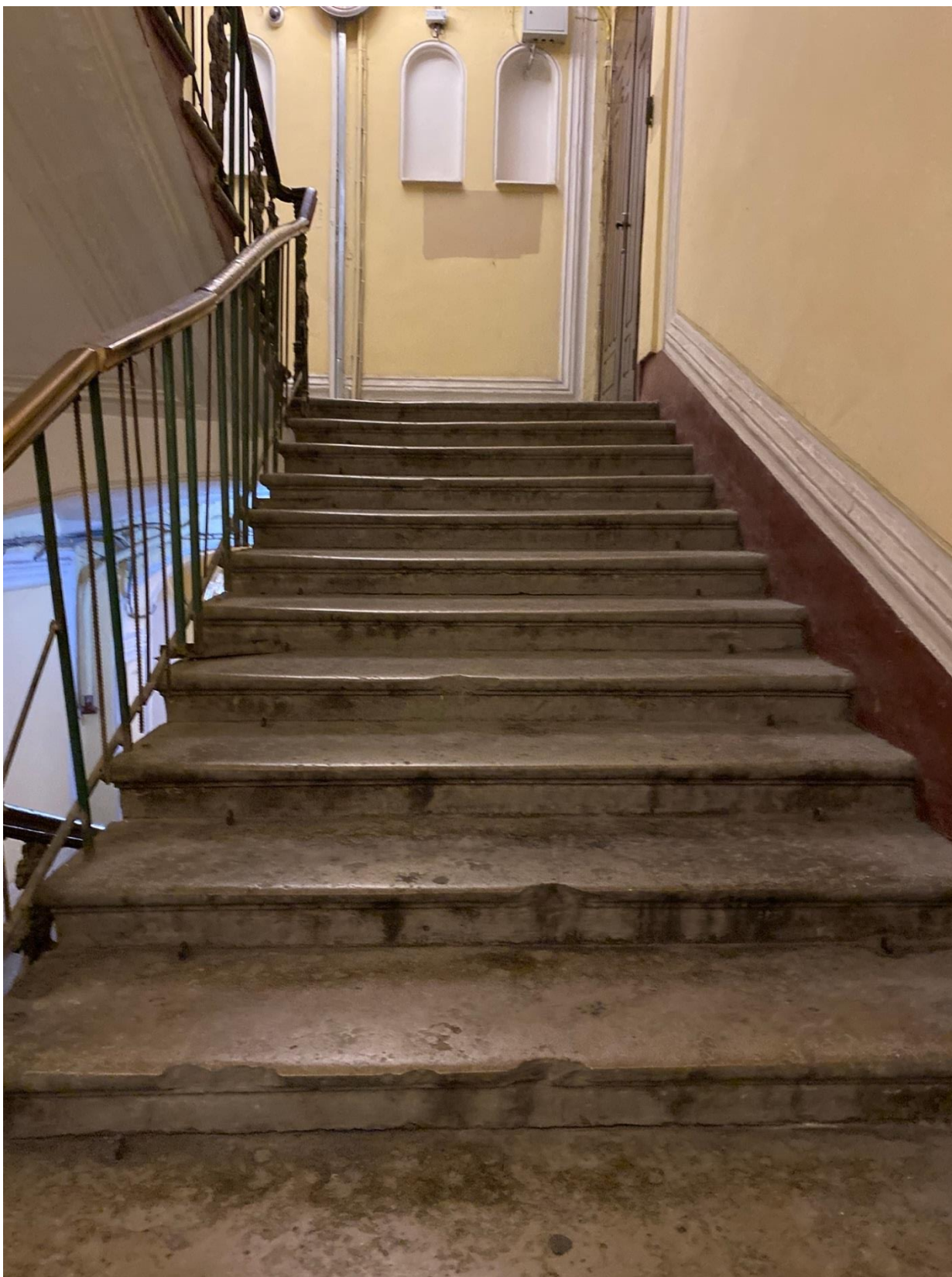
Фото 12. Вид на парадную лестницу объекта культурного наследия.
