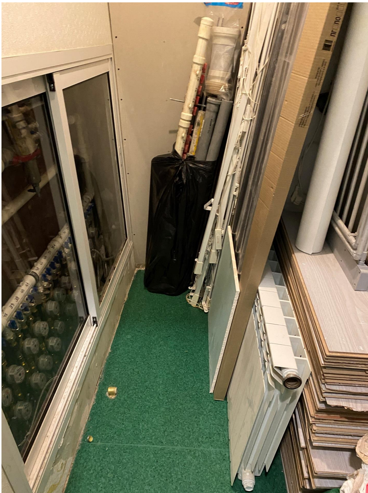
Фото 70. Вид на помещение квартиры № 10 объекта культурного наследия.
