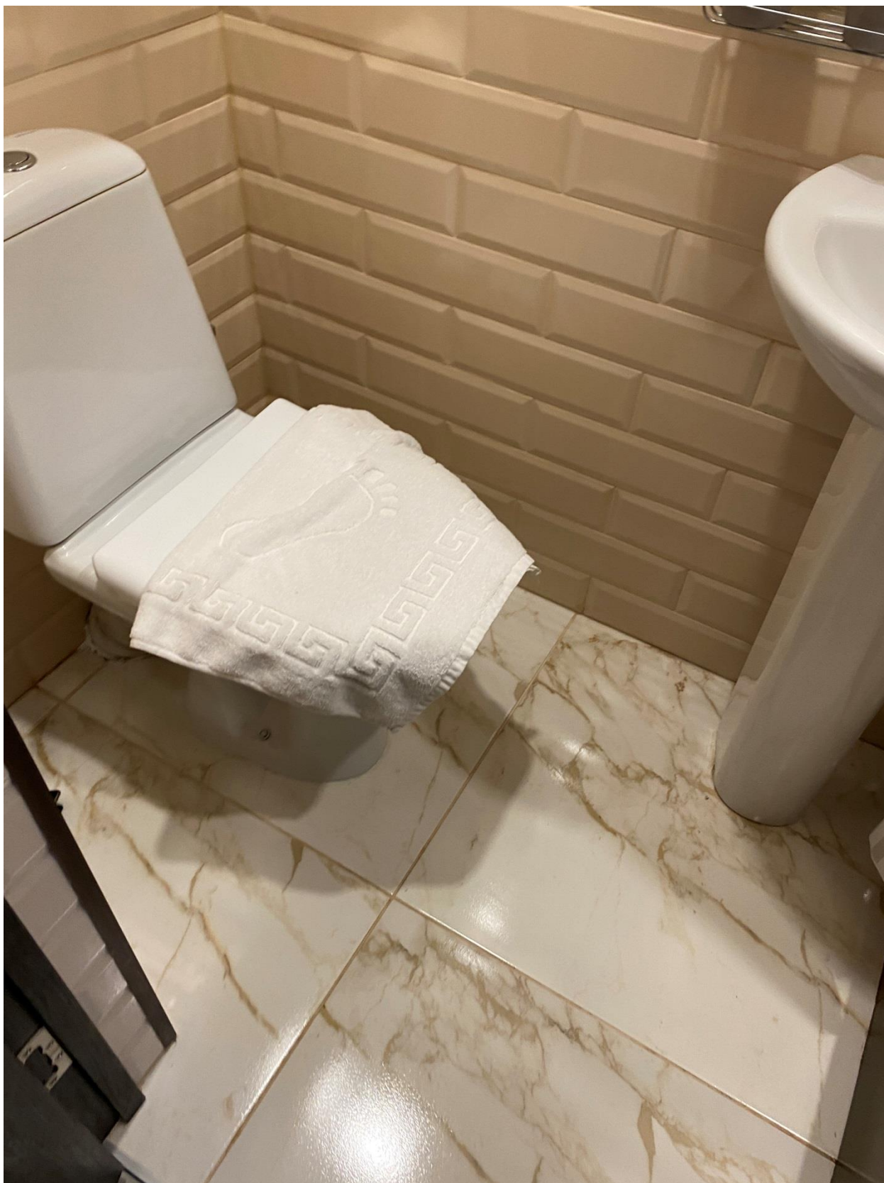
Фото 56. Вид на помещение квартиры № 10 объекта культурного наследия.
