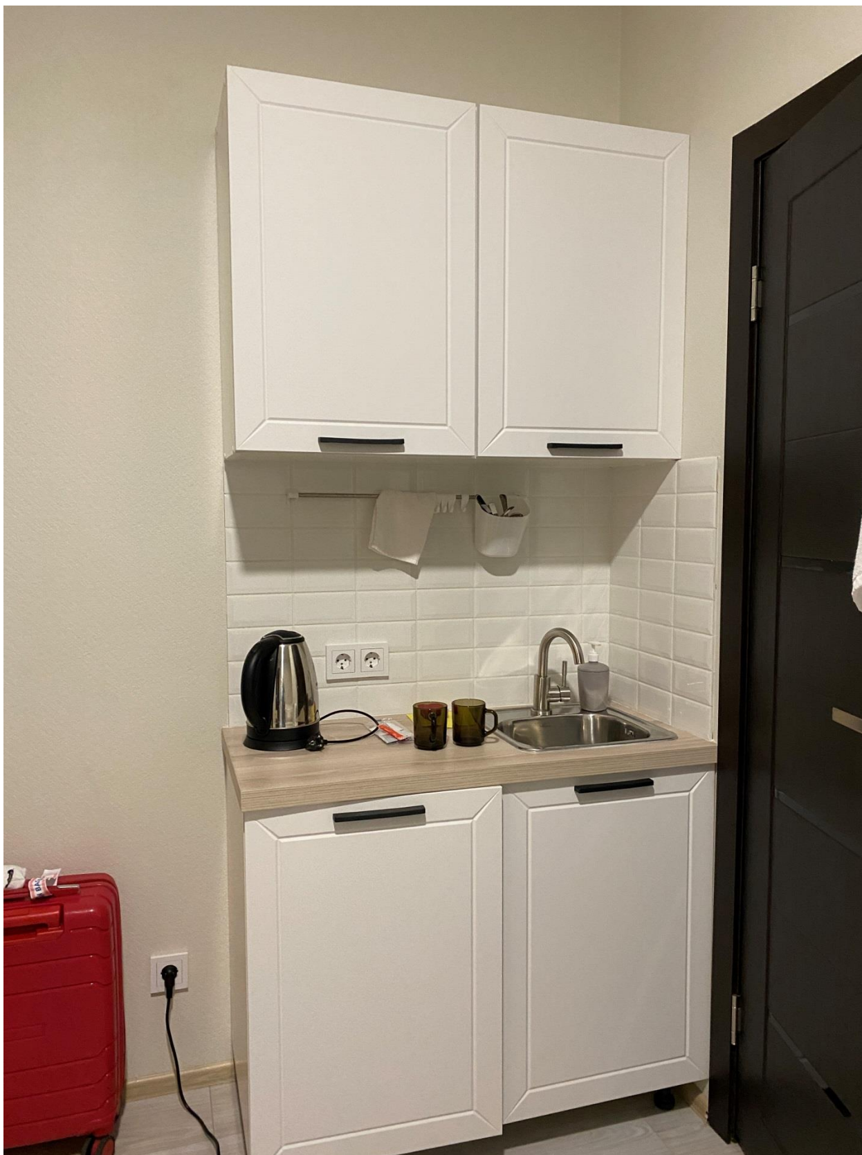
Фото 65. Вид на помещение квартиры № 10 объекта культурного наследия.
