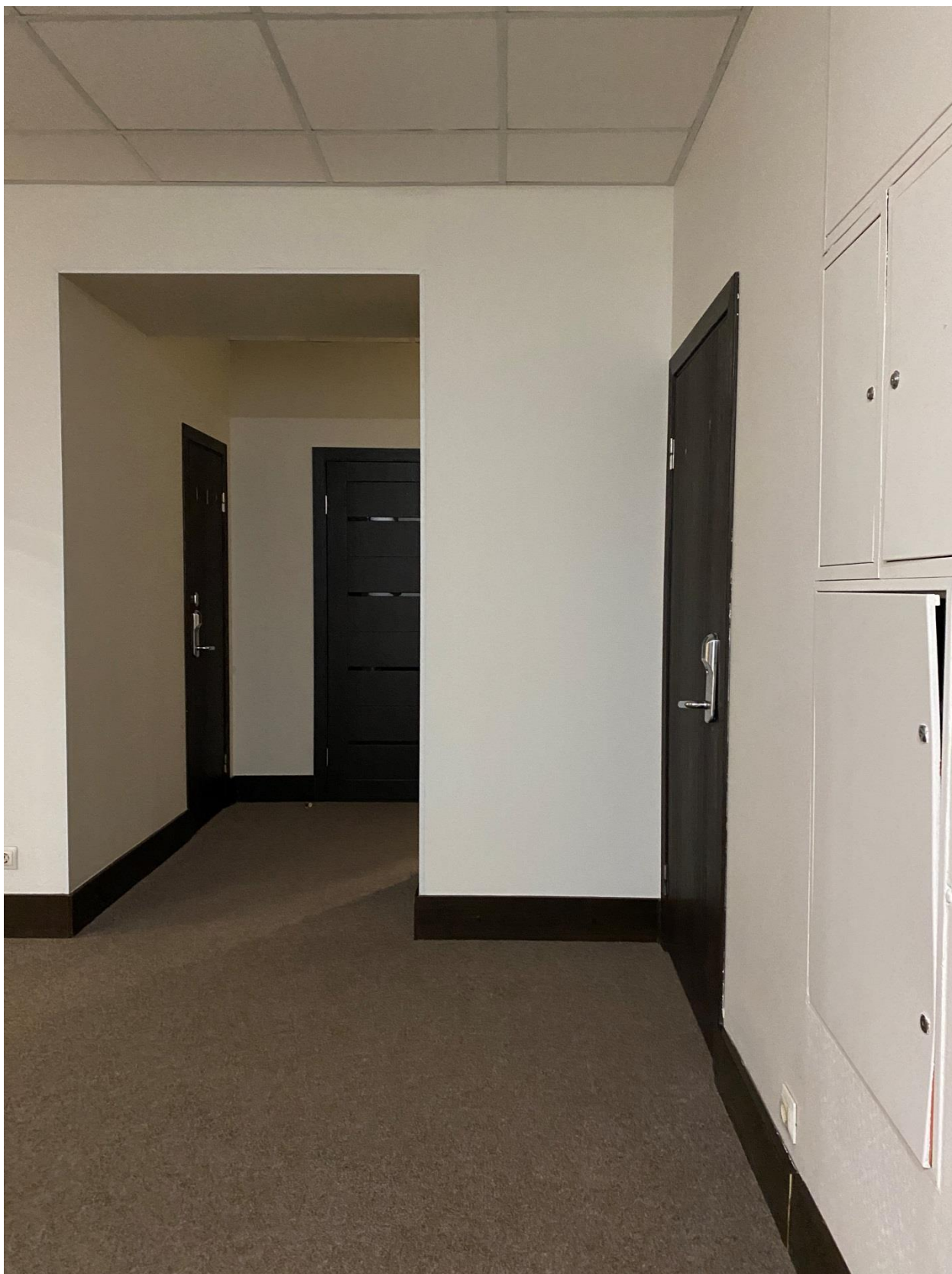
Фото 19. Вид на помещение квартиры № 10 объекта культурного наследия.
