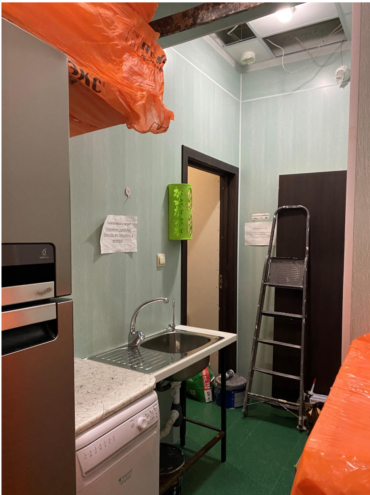
Фото 69. Вид из помещения квартиры № 10 объекта культурного наследия.
