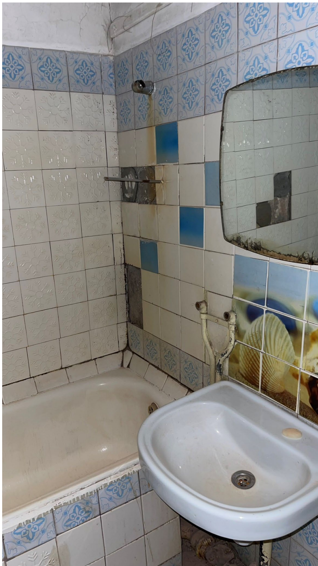
17.Фрагмент интерьера ванной (помещение 7/2.9);
