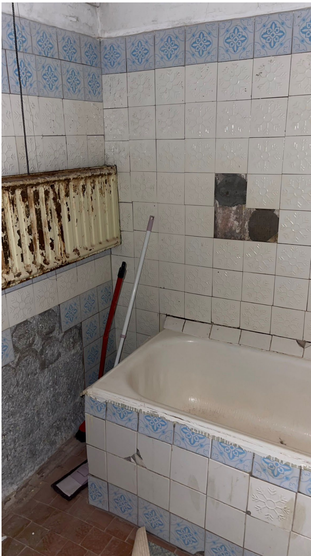
16. Фрагмент интерьера ванной (помещение 7/2.9);
