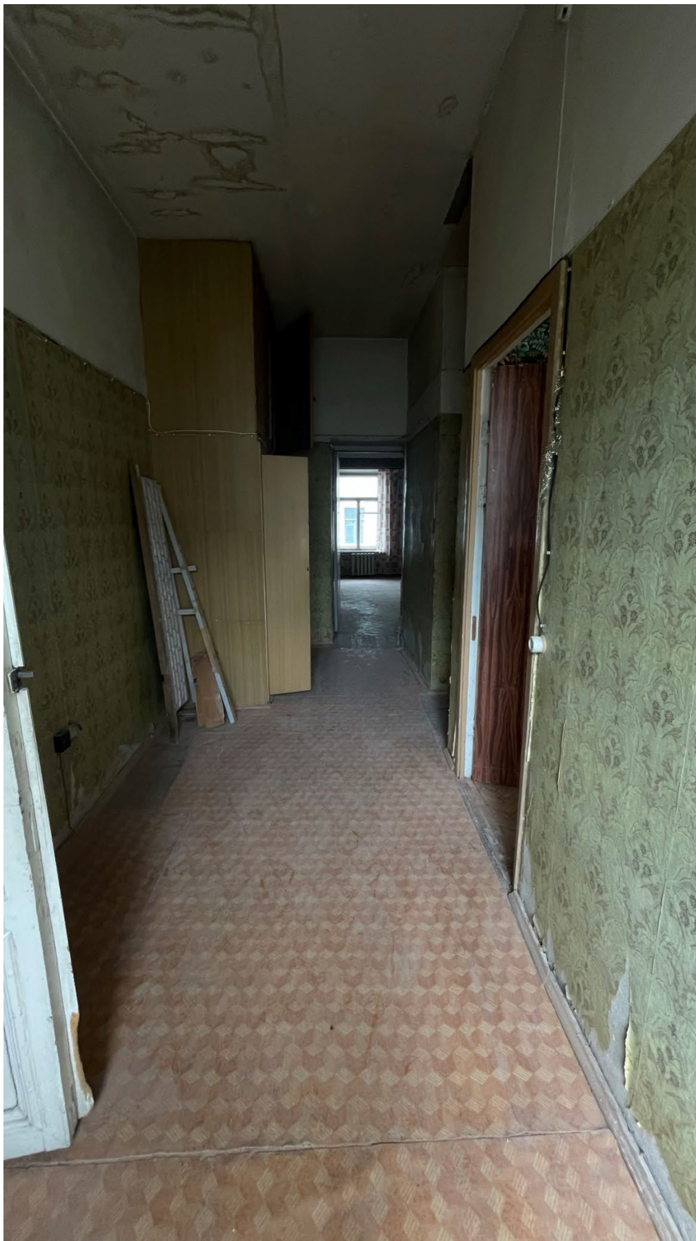
5. Фрагмент интерьера коридора (помещение 1/15.4);
