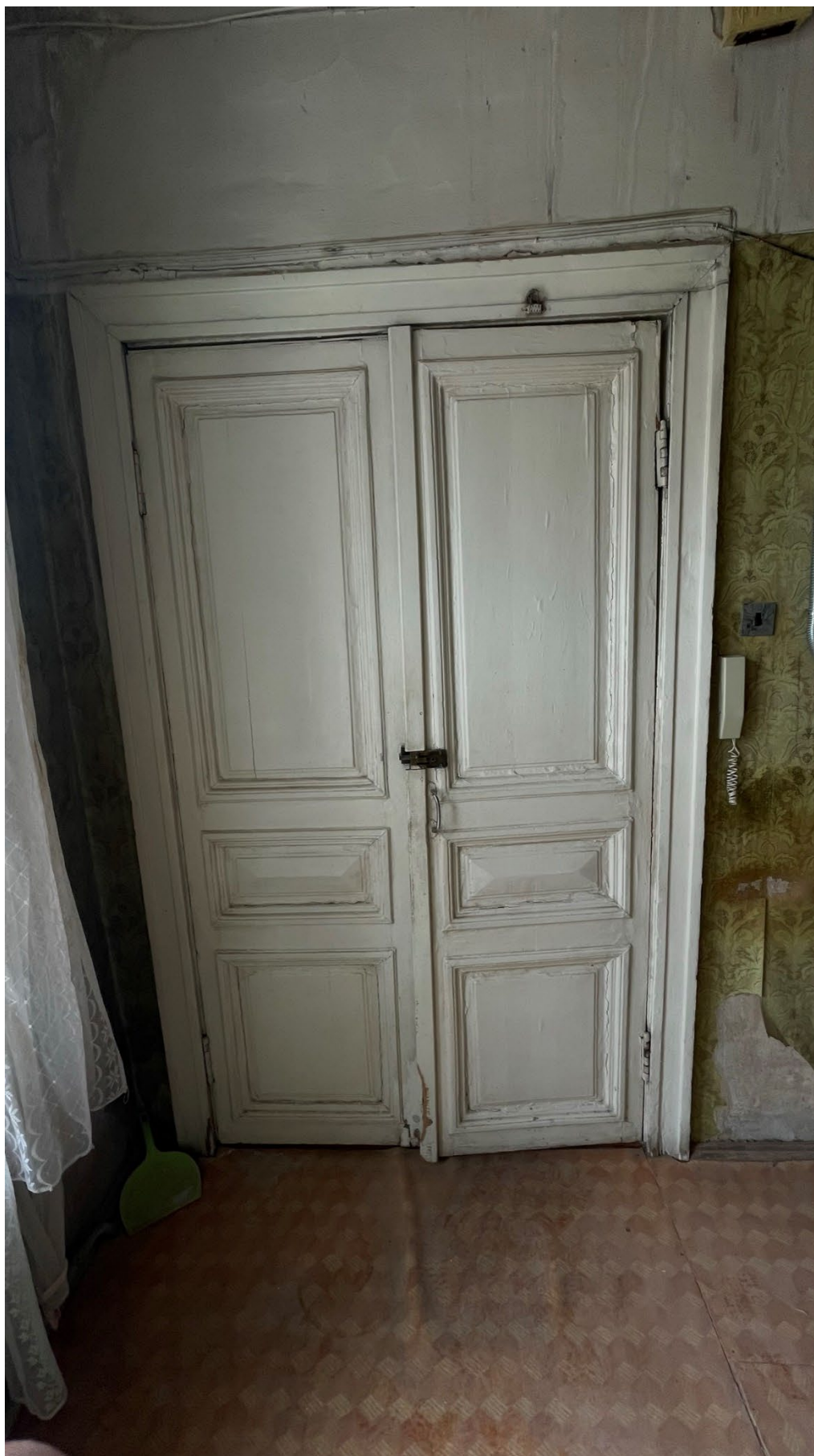
4. Вид на входную дверь в квартире;
