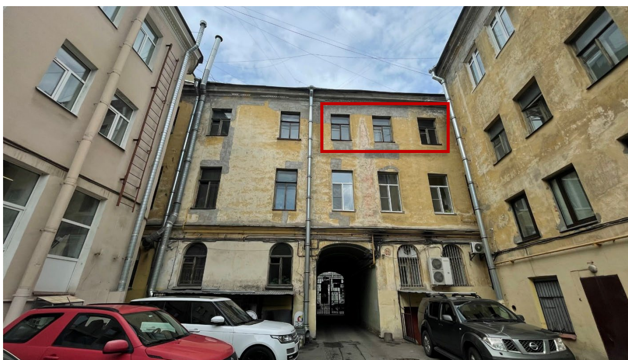
2. Вид на дворовой фасад здания и окна квартиры по адресу: г. Санкт-Петербург, Караванная ул., д. 24-26, лит. А;
