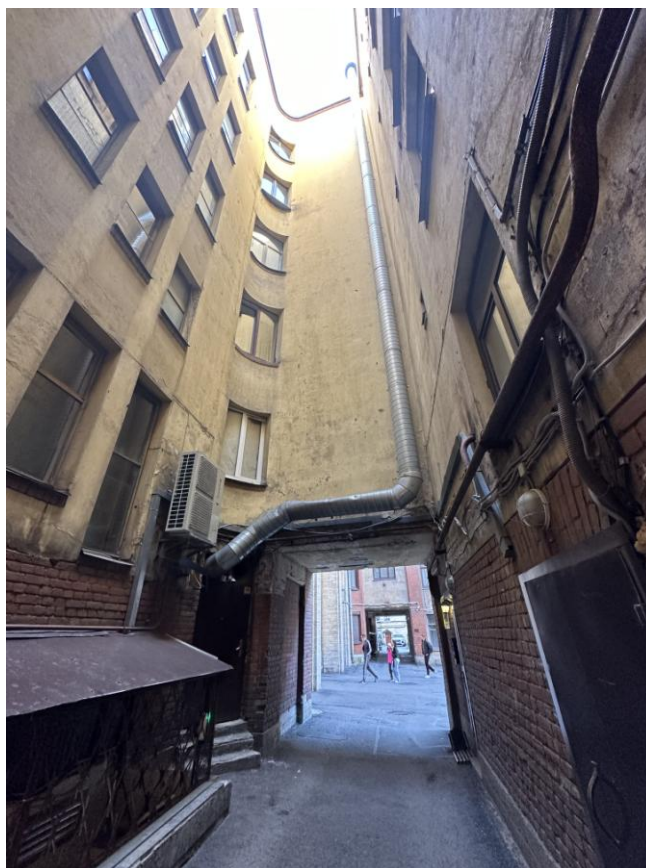
Фото 7. Фрагмент дворового фасада объекта культурного наследия регионального значения «Бывший дом Толстого (фасады)»
