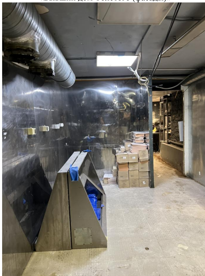
Фото 20. Интерьер пом. 2-Н объекта культурного наследия регионального значения «Бывший дом Толстого (фасады)»
