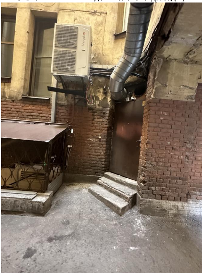
Фото 8. Фрагмент дворового фасада объекта культурного наследия регионального значения «Бывший дом Толстого (фасады)»
