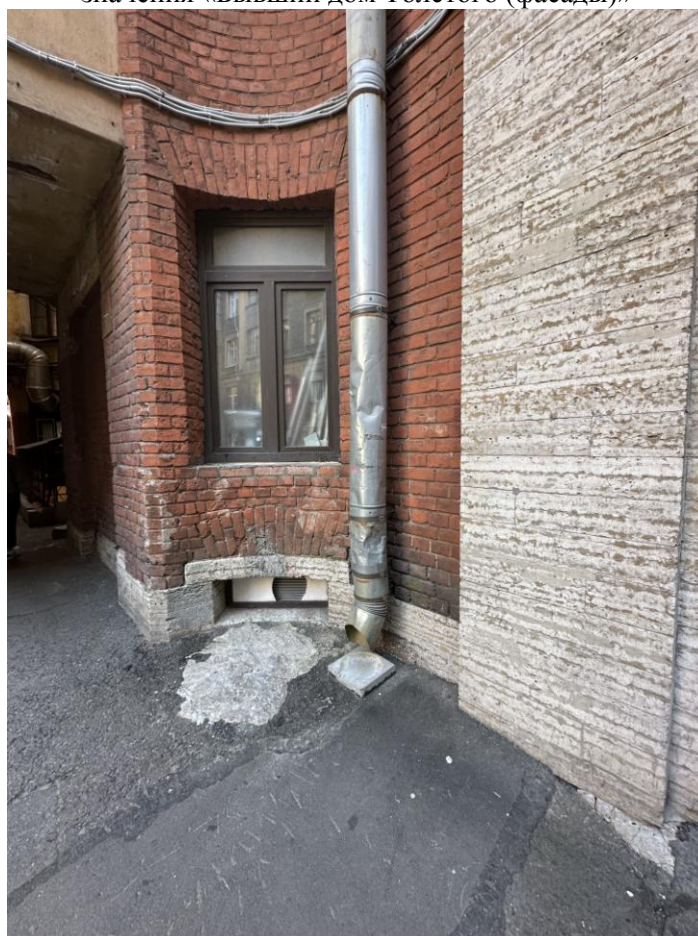
Фото 6. Фрагмент дворового фасада объекта культурного наследия регионального значения «Бывший дом Толстого (фасады)»
