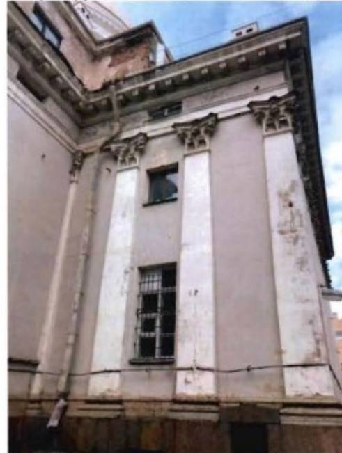
4. Фрагмент юго-восточного фасада объекта культурного наследия.
