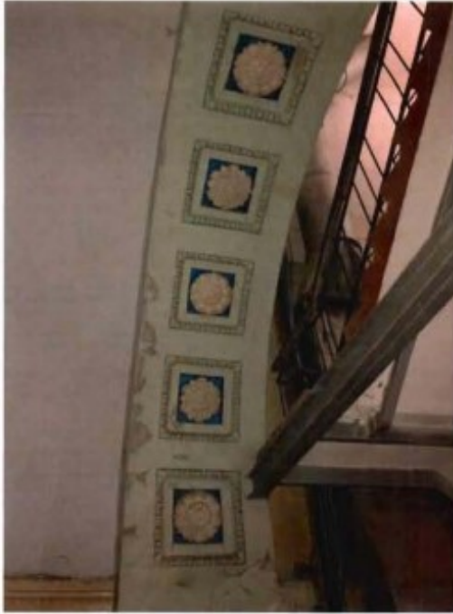
9. Внутренняя планировочная структура объекта культурного наследия. Лепной декор на подпружных арках.
