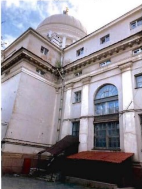
3. Фрагмент северо-западного фасада объекта культурного наследия.
