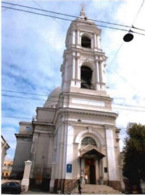
1. Юго-западный фасад объекта культурного наследия.
