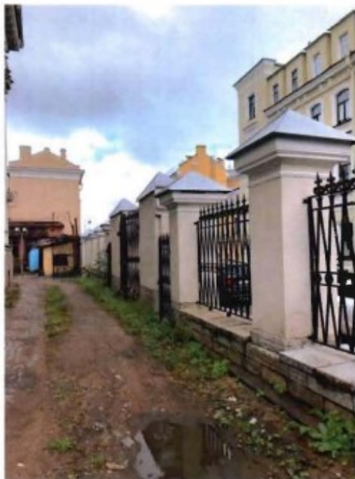
16. Фрагмент ограды вдоль Тучкова переулка. Юго-западный фасад.
