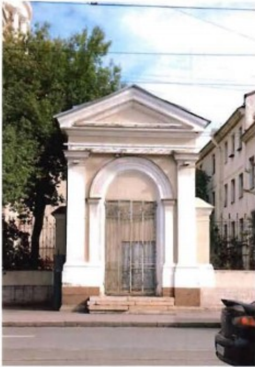
13. Юго-западный фасад юго-восточной Часовни.
