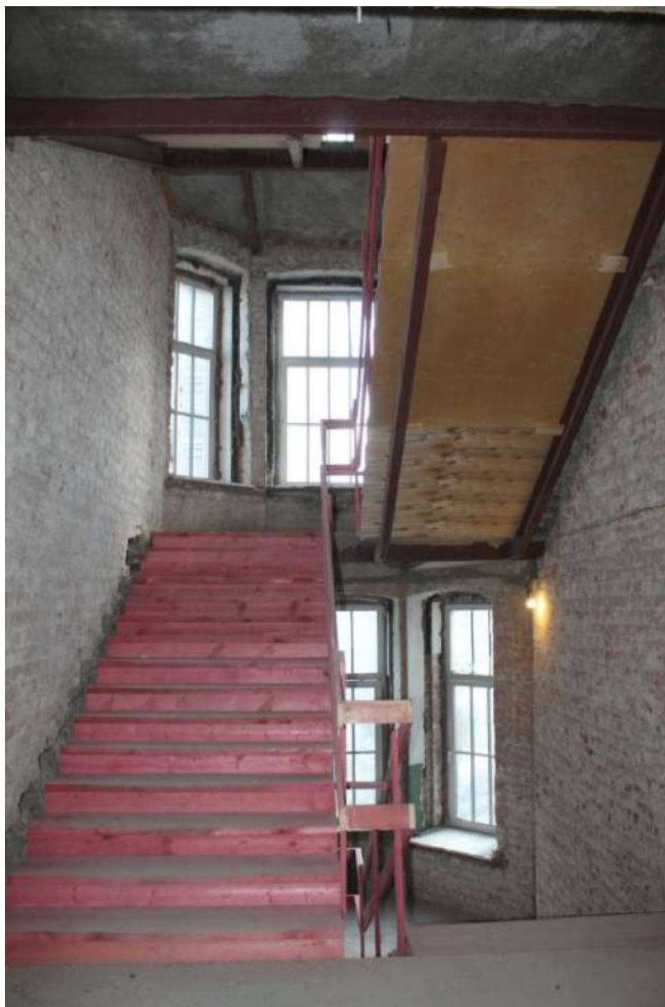
7. Лестничные марши. Выявленный объект культурного наследия «Конторское здание», расположенного по адресу: г. Санкт-Петербург, ул. Черниговская, д.13.
