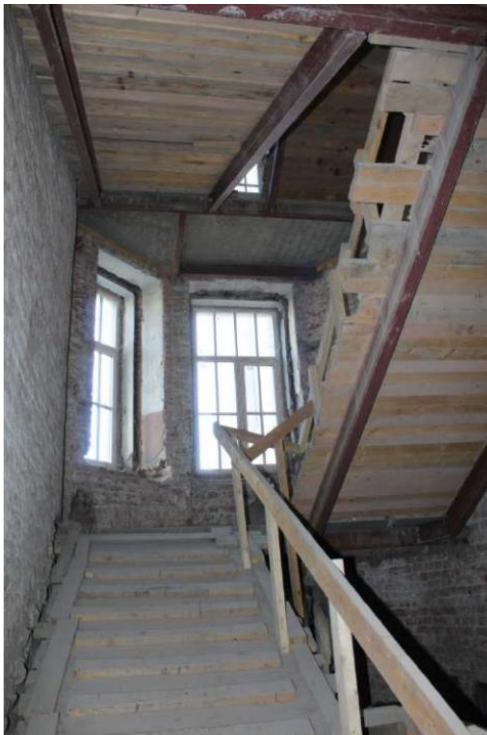
б. Лестничные марши. Выявленный объект культурного наследия «Конторское здание», расположенного по адресу: г. Санкт-Петербург, ул. Черниговская, д.13.
